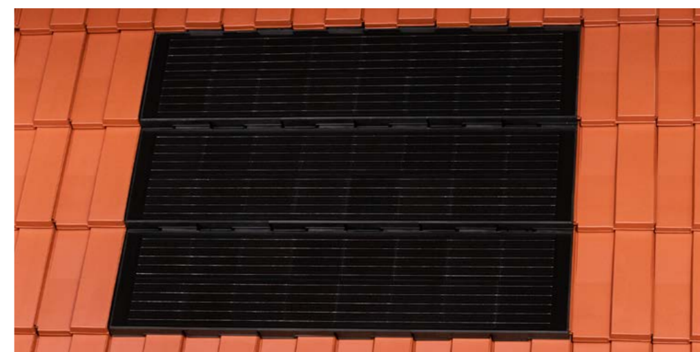
J160-PV eingedeckt mit J160 in altrot
