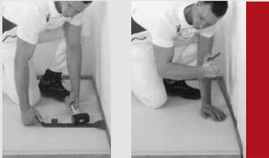
Die Randplatten können mit Hilfe eines Zugeisens oder Montier eisens leicht eingesetzt werden. Nach Abschluss der Arbeiten müssen evtl. gesetzte Keile wieder entfernt werden.
