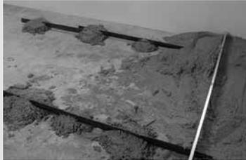
Die NORIT-Gebundene Schüttung wird nun im Bereich zwischen den Dämmen (Mindestschütthöhe: 10 mm) oder den Profilen (Mindestschütthöhe: 50 mm) eingebracht. Auch über Kabeln und Rohrleitungen; maximale Schichtstärke pro Arbeitsgang 300 mm.
