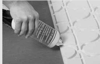
Die Verbindungsflächen müssen trocken, staub- und fettfrei sein. Der NORIT-TE-Klebstoff wird auf die Anlegezone des schon verlegten Elements aufgebracht. Dabei kann die Flasche an der oberen Plattenkante entlang geführt werden, so dass der Klebstoff (Verbrauchsmenge 18 g/m<sup>2</sup>) hinter der Rille aufgetragen wird. Die Rohrnut wird nicht mit TE-Klebstoff benetzt.
