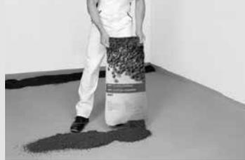
In der Ecke, die von der Tür am weitesten entfernt ist, wird der erste Damm (Breite ca. 200 mm) geschüttet. Auf dem Damm wird die Grundschiene vollflächig aufgelegt und auf die entsprechende Höhe ausgerichtet (Nivelliergerät oder Schlauchwaage verwendet).
