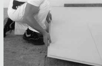
Die Trockenestrichelemente werden schräg angesetzt und dann mit leichtem Druck gegen die bereits verlegte Platte abgelegt. Bei der weiteren Verlegung ist auf eine geschlossene Längsfuge zu achten. Dehnungsfugen sind erst ab einer Raumlänge von 20 m (bei Fußbodenheizungen bis 50 °C, ab 10 m) vorzusehen.
