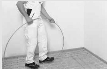
Das NORIT-Heizrohr wird nach der Vorgabe des Fachplaners verlegt. Es ist darauf zu achten, dass das Rohr sauber in die fix-Führung einklickt, es darf nicht verdrillen oder knicken. Die max. Heizkreislänge von 80 m kann durch
