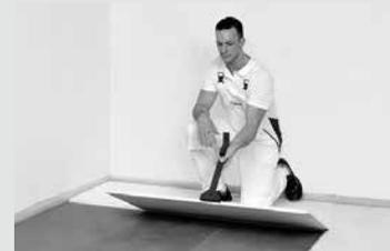
Abschließend kann die NORIT-Trockenschüttung ohne Nachverdichten direkt mit dem einzigartigen NORIT-Trockenestrich oder der innovativen NORIT-Fußbodenheizung belegt werden. Hinweis: Um ein Betreten der Schüttung zu vermeiden, können die Elemente auch mit Hilfe des Zugeisens abgelassen werden (siehe Foto). Weitere Informationen finden Sie auf unserer Internetseite.
