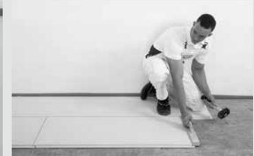
Anschließend werden die Elemente stirnseitig mittels Hammer und NORIT-Haudegen zusammengefügt. Direktes Schlagen mit dem Hammer auf die Trockenestrichelemente kann zu Beschädigungen führen.
