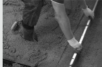
Der Bereich zwischen den Dämmen/Profilen kann mit Hilfe einer Estrichabziehle planeben abgezogen werden. Die NORIT-Nivellierprofile verbleiben in der abgezogenen Schüttung. Zur Optimierung der Ebenheit kann die Oberfläche zusätzlich mit einer Glättscheibe bzw. einem Glättschwert geglättet werden. Nach ca. 24 Stunden ist die NORIT-Gebundene Schüttung begehrbar.
