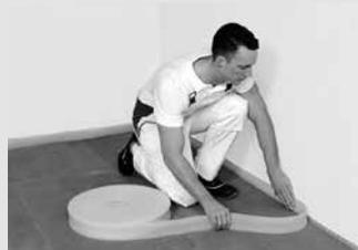
Zur Vermeidung von Schallbrücken, wird der Randdämmstreifen (Dicke mind. 10 mm) auf die NORIT-Trockenschüttung bzw. auf die Dämmung gestellt.
