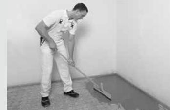
Sonneneinstrahlung und Zugluft vermieden werden. Die Verarbeitungszeit beträgt 15 - 20 Minuten. Ein zweites Vergießen ist ggf. nass in nass sofort nach Begehbarkeit (2 - 4 Stunden) durchzuführen. Vor einem zweiten Vergießen nach Austrocknung der Vergussmasse muss diese nochmals grundiert werden.
