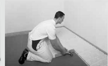
Die Elemente werden stirnseitig mittels Hammer und NORIT-Hautdegen zusammengefügt. Direktes Schlagen mit dem Hammer auf das Klick-Profil kann zu Beschädigungen führen. Dehnungsfugen sind erst ab einer Raumlänge von 20 m vorzusehen.
