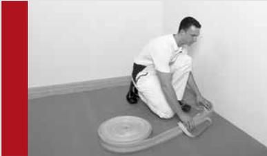
Vor der Verlegung der TE Therm-Elemente wird umlaufend der NORIT-Randdämmstreifen angebracht. Die befestigte Folie wird voll ausgebreitet in den Raum gelegt. In Ecken wird die Folie überlappt. An Kanten wird eine zusätzliche Folie zur Abdichtung angebracht. Das Abkleben von Stößen des Randdämmstreifens und der Schleppfolie ermöglicht ein sicheres Vergießen der Fläche.
