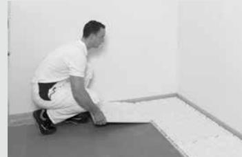
Die TE Therm-Elemente werden schräg angesetzt und mit leichtem Druck gegen die bereits verlegte Platte abgelegt. Bei der weiteren Verlegung ist auf eine geschlossene Längsfuge und die richtige Ausrichtung am Plattenlayout zu achten. (siehe: Grafik links)
