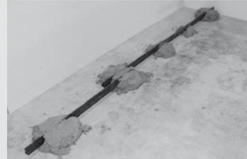
Dämme mit NORIT-Gebundener Schüttung direkt an der Wand oder mit einem Wandabstand von ca. 50 cm in entsprechender Höhe ausrichten.
