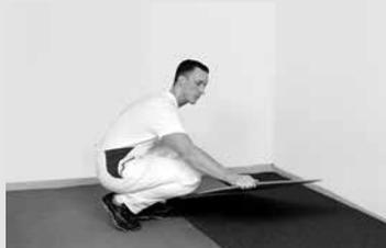
Um ein sauberes Verlegen des Trockenestrichs zu erleichtern, kann optional eine Trennschicht auf der Schüttung angeordnet werden. Diese wird von der Tür ausgehend in den Raum hinein verlegt. Hierzu eignen sich Dämmplatten oder Kraftpapier. Die Dämmung sollte im Verbund verlegt werden, um Kreuzfugen zu vermeiden.
