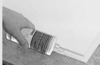
Die Verbindungsflächen müssen trocken, staub- und fettfrei sein und dürfen nicht beschädigt sein. Der Klebstoff wird auf die Anlegestelle des verlegten Elements aufgebracht. Dabei kann die Flasche an der oberen Plattenkante entlang geführt werden, so dass der Klebstoff (Verbrauchsmenge ca. 18 g/m<sup>2</sup>) neben der Rille aufgetragen wird.
