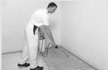
Die rötliche Grundierung wird mit einem Drucksprüher gleichmäßig aufgebracht. Um auch die Flanken der Ausfräsungen vollständig zu grundieren, wird das kreuzweise Sprühen aus mehreren Richtungen empfohlen. Die NORIT-Grundierung wird im Verhältnis 1:4 (Grundierung: Wasser) gemischt. Die zu erzielende Auftragsmenge des Gemisches von 150 g/m<sup>2</sup> kann mit der Farbtafel überprüft werden.
