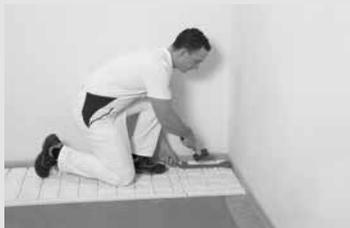
Die Randplatten können mit Hilfe eines TE-Zugeisens leicht eingesetzt werden. Nach Abschluss der Arbeiten müssen evtl. gesetzte Keile entfernt werden. Zur Vorbereitung auf die folgenden Arbeitsschritte muss die Fläche staubfrei und frei von Verschmutzungen sein.
