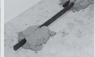
Alle folgenden Dämme/Profile werden parallel zum Ersten verlegt. Der Abstand ist abhängig von der Länge der Abziehlehre. Höhenkontrolle mit Schlauchwaage/Nivelliergerät.
