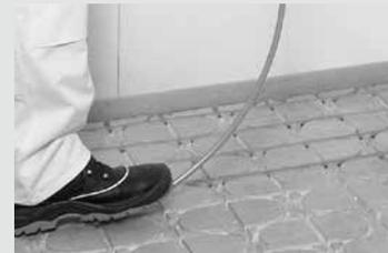
die laufende Markierung auf dem Rohr kontrolliert werden. Wird das Heizrohr durch aufsteigende Bauteile oder Zwischendecken verlegt, muss dies durch ein geeignetes Schutzrohr geführt werden.
