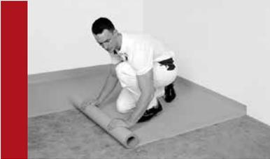
Nachdem der Untergrund vorbereitet wurde, kann eine Folie oder ein Rieselschutz mit einer Überlappung von min. 200 mm ausgelegt werden. Dabei ist das Material im Randbereich wannenartig ca. 50 mm über die Oberkante des fertigen Bodens zu ziehen und zu fixieren. Unter dieser Schicht sind Luft einschüsse besonders im Eckbereich zu vermeiden.
