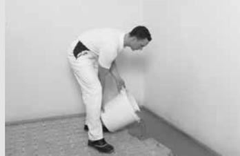
Zum Verfüllen der Fläche wird ein Sack Vergussmasse (25 kg) mit 6 l Wasser klumpenfrei angerührt und anschließend auf der Fläche verteilt. Um die Mindestüberdeckung von 3 mm über den Elementen einzuhalten, wird die Verwendung einer Zahnrakel empfohlen. Die Bedarfsmenge beträgt ca. 11 kg/m<sup>2</sup>. Während der Trocknung sollte direkte
