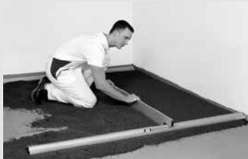
Die Fläche zwischen den Grundschienen kann mit Hilfe der Abziehle abgezogen werden. Hierbei sollte man besonders sorgfältig arbeiten, da nur eine ebene Fläche das gute Verlegeergebnis des Trockenestrichs garantiert. Die abgezogene Trockenschüttung sollte nur noch auf Laufinseln (Plattenmaterial, z. B. Holzweichfaser, EPS, XPS) betreten werden.
