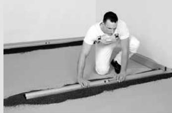
Der zweite Damm wird parallel zum Ersten im Abstand der Länge der Abziehlehre ausgeschüttet. Mit Hilfe der Abziehlehre kann dieser auf die gleiche Höhe gebracht werden.
