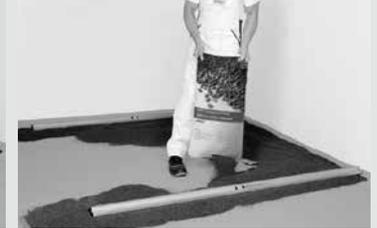
Die NORIT-Trockenschüttung wird nun im Bereich zwischen den Dämmen eingebracht (Mindestschütthöhe: 15 mm, auch über Kabeln und Rohrleitungen; maximale Schütthöhe: 100 mm). Mit einer Glattscheibe kann das Material auch im Eckbereich gleichmäßig verteilt werden. Zu diesem Zeitpunkt kann der Bereich zwischen den Dämmen problemlos betreten werden.
