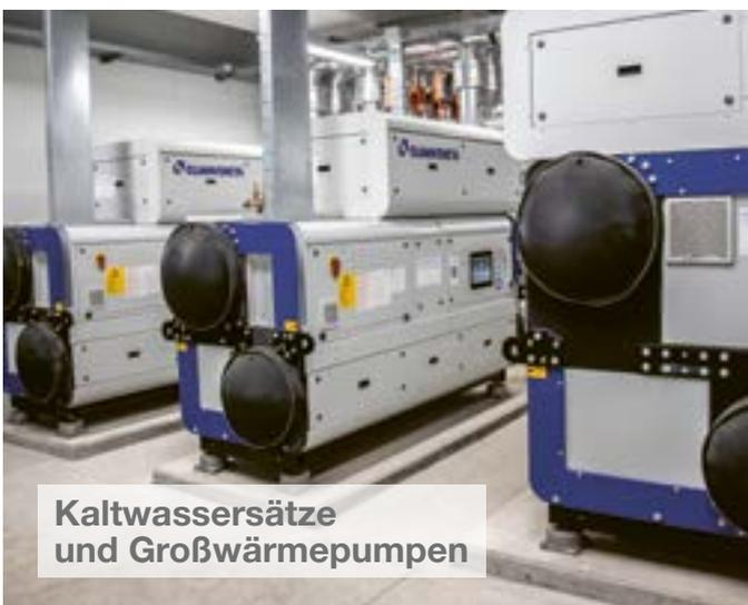
Kaltwassersätze und Großwärmepumpen
