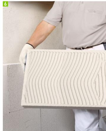
6 Mörtel vollflächig auf Mineraldämmplatte
