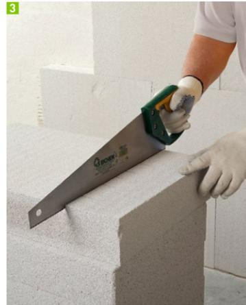
3 Multipor Mineraldämmplatte schneiden
