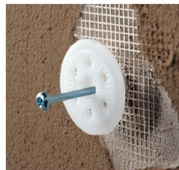
Setzen des Dübels durch das Gewebe
