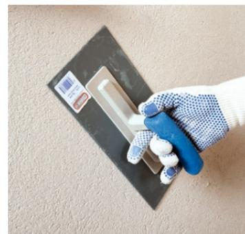
Strukturieren mittels Traufel
