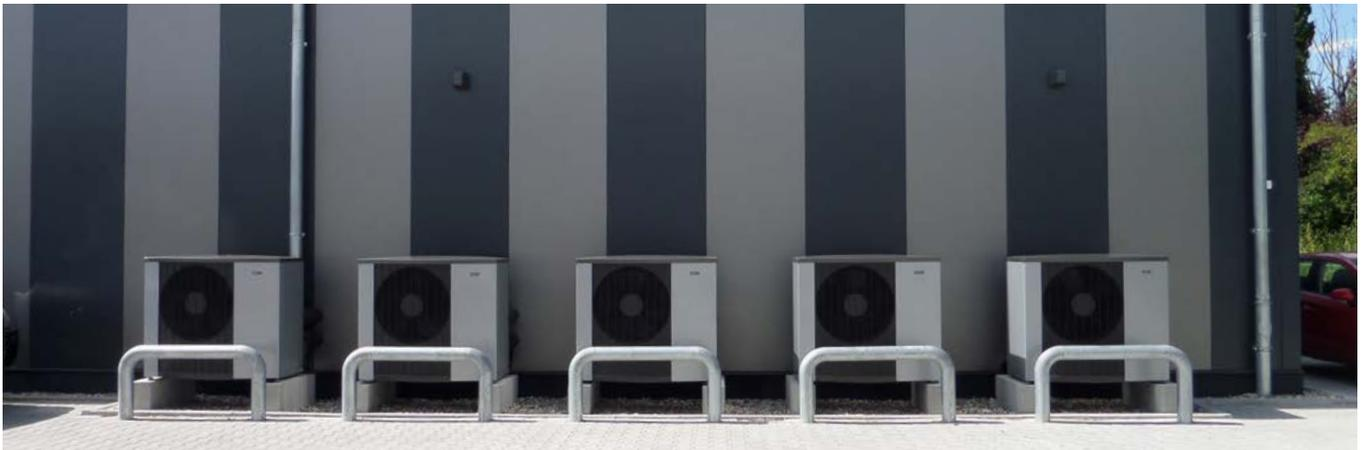
Mit der Regeleinheit SMO S40 können bis zu acht Luft/Wasser-Wärmepumpen S2125/F2120 in Kaskade betrieben werden.
