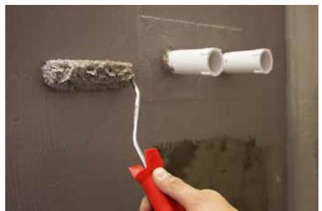
**6** Zur Abdichtung der Flächen Sopro FlächenDicht flexibel satt auftragen. Der Auftrag der zweiten Schicht erfolgt nach ausreichender Festigkeit der ersten Schicht.
