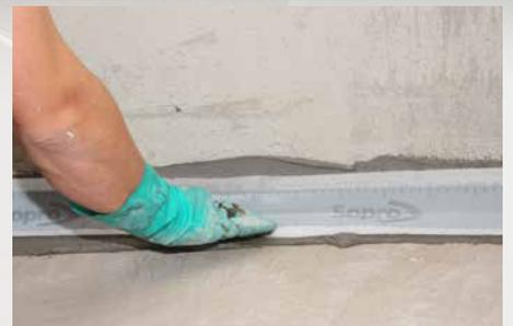
**3** Im Bereich von Anschluss- und Bewegungsfugen Sopro Dichtband/Sopro Dichtband mit Falz einlegen, einbetten und komplett mit dem Abdichtungsstoff überarbeiten.
