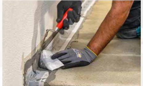
**3** ... des anschließend einzulegenden Sopro Dichtbandes/Sopro Dichtbandes mit Falz, das zusätzlich fest anzudrücken ist.
