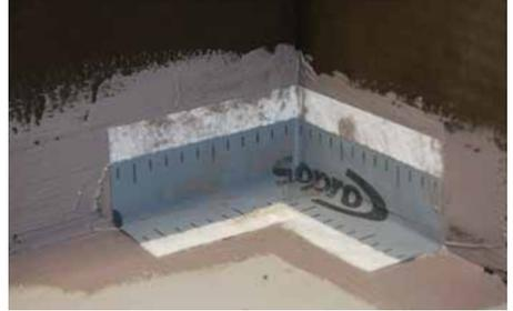
**2** Im Bereich von Innen- bzw. Außenecken die vorgeformten Sopro Dichtecken einlegen.
