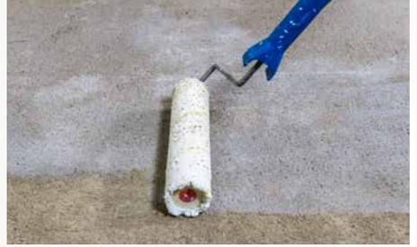
**1** Vornässen bzw. Grundieren des Untergrundes für den nachfolgenden Auftrag einer flexiblen Sopro Dichtschlämme (z. B. Sopro TurboDichtSchlämme 2-K).
