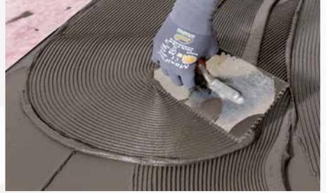
**1** Zunächst wird ein flexibler Sopro Fließbettmörtel (z. B. Sopro megaFlex S2 turbo) auf die mit Gefälle vorbereitete Fläche aufgezogen.
