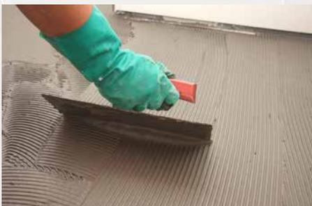
**4** Die erste Abdichtungsschicht mit einer Zahnung (4–6 mm) aufziehen (z. B. Sopro DSF®1-K) ...
