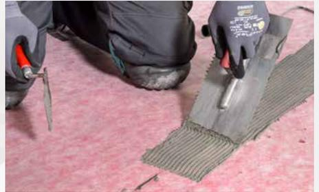
**3** Im Stoßbereich wird Sopro TurboDichtSchlämme 2-K auf die Sopro AEB® plus aufgetragen und mit einem feingezahnten Spachtel aufgekämmt.
