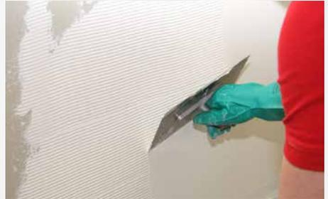
2 Sopro PU-FlächenDicht Wand aufzahn und anschließend die Kammstege umlegen. Erforderliche Nass-Schichtdicke pro Abdichtungsschicht: 0,6 mm.
