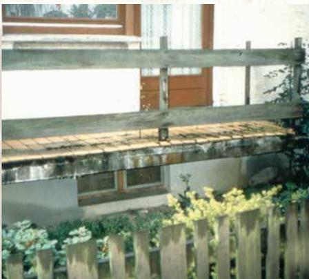
Beschädigter Fliesenbelag aufgrund fehlerhafter Balkonkonstruktion
