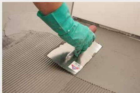
**5** ... und anschließend die Kammstege umlegen. Mindestschichtdicke pro Abdichtungsschicht beachten.
