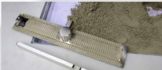
**1** Die mit Fliesenkleber (Sopro's No. 1 als Haftbrücke) rückseitig abgespaltelte Rinne wird in den frischen Estrichmörtel aus Sopro Rapidur® M1 oder Sopro Rapidur® M5 eingearbeitet.
