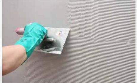
4 Der Auftrag der zweiten Abdichtungsschicht erfolgt analog der ersten Schicht durch Aufzahn und Umlegen der Kammstege.
