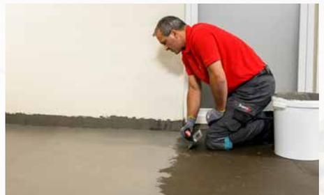
**6** Nach Durchtrocknung der ersten Abdichtungsschicht wird die zweite Abdichtungsschicht aufgebracht. Die Gesamt-Trocken-Schichtdicke muss mindestens 2 mm betragen.
