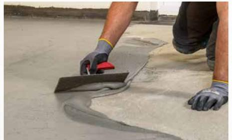
**5** Die erste Abdichtungsschicht wird gespachtelt oder mit der Lammfellrolle aufgetragen, wobei das Sopro Dichtband nahtlos in die Abdichtung eingebunden wird.
