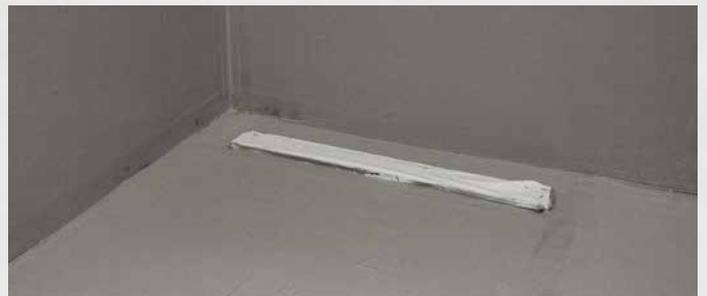
4 Komplett abgedichtete Duschcke in zwei Arbeitsgängen (Wand- und Bodenfläche) mit Sopro DSF® 1-K, bereit für die folgende Fliesenverlegung.
