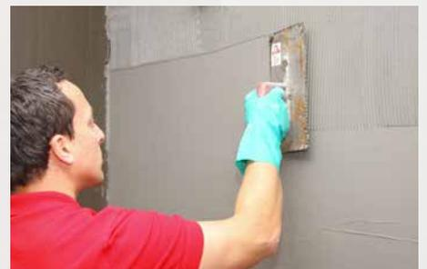
**6** Nach ausreichender Trocknung der ersten Schicht erfolgt der Auftrag der zweiten Abdichtungsschicht (z. B. Sopro DSF®1-K).
