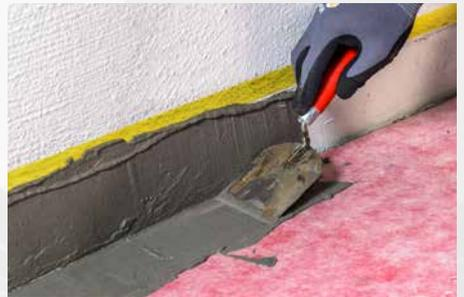
**5** Der Sockelbereich wird mit flexiblem Sopro Dünnbettmörtel aufgespachtelt. Der angrenzende Bereich mit Sopro TurboDichtSchlämme 2-K aufgezant.
