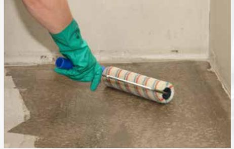
1 Den Untergrund mit Sopro Epoxi-Grundierung vorbehandeln und mit Sopro Quarzsand fein absanden.
