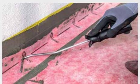
**6** Einlegen des Sopro AEB® Dichtbandes zur Abdichtung des Sockelbereichs.
