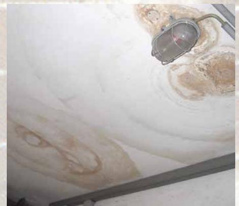
Feuchtigkeitsschaden an der Decke unter schadhafter Abdichtung
