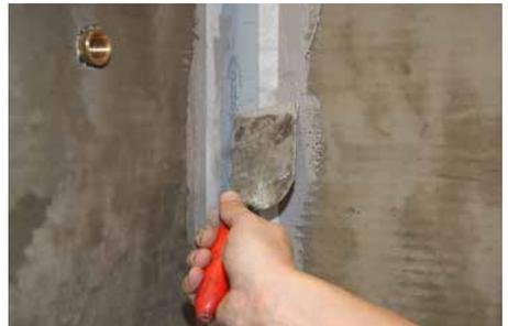
**3** In Eckbereichen bzw. dem Anschlussbereich von Boden- und Wandflächen Sopro Dichtband/ Sopro Dichtband mit Falz einlegen und komplett mit dem Abdichtungsstoff überarbeiten.
