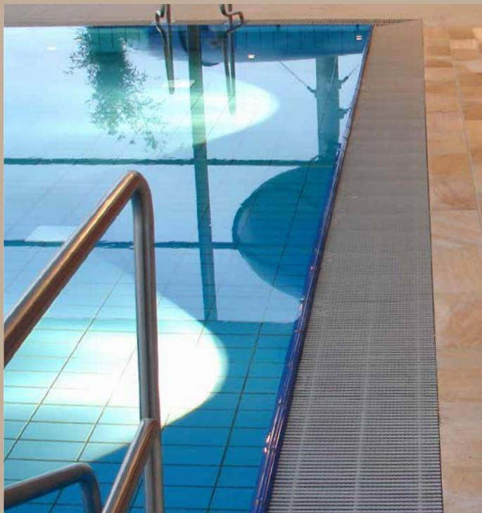
Hochliegender Wasserspiegel, bei dem die besonders sorgfältige Ausführung der kapillarbrechenden Fuge von größter Bedeutung ist
