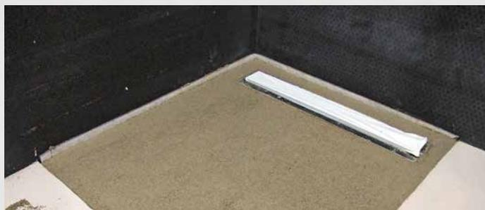
**2** In den Estrichmörtel aus Sopro Rapidur® M1 oder Sopro Rapidur® M5 fertig eingebaute Rinne.
