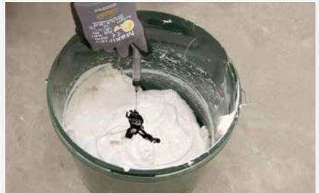
3 Nach 8–24 Stunden die zweite Abdichtungsschicht aufbringen. Zur besseren Unterscheidbarkeit kann die zweite Abdichtungsschicht mit Sopro PU-FlächenDicht Kontrastfarbe eingefärbt werden.
