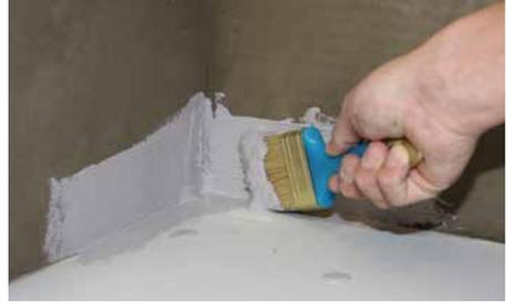
**1** Zunächst im Eckbereich und im Anschlussbereich von Boden- und Wandfläche Sopro FlächenDicht flexibel auftragen.
