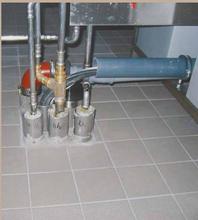
Hüllrohre (Sonderanfertigung) zur Durchführung von Versorgungsleitungen
