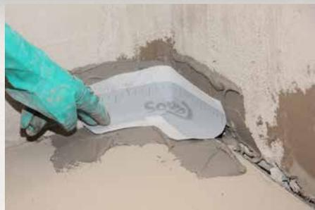
**2** Im Bereich von Innen- und Außenecken den Abdichtungsstoff aufbringen, die vorgeformten Sopro Dichtecken einlegen und gut andrücken.
