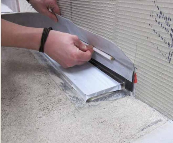
Verkleben des Sopro FlexDichtBandes mit Schlaufe als Übergang zwischen dem Metallflansch der Rinne und den angrenzenden Baustoffen.
