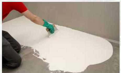
6 Im Bodenbereich das selbstverlaufende Sopro PU-FlächenDicht Boden mittels Sägezahnleiste in zwei Schichten auftragen, mittels Stachelwalze entlüften und die zweite Abdichtungsschicht mit Sopro Quarzsand grob absanden.
