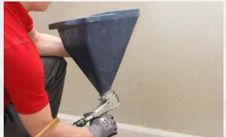
5 Nach 5–10 Minuten die zweite Abdichtungsschicht mit Sopro Quarzsand grob absanden.
