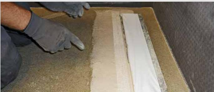
3 Eindichten des Rinnenkörpers mit Sopro DSF® 1-K. Der Übergang wird durch Einlegen eines Armierungsgewebestreifens in die Verbundabdichtung verstärkt.
