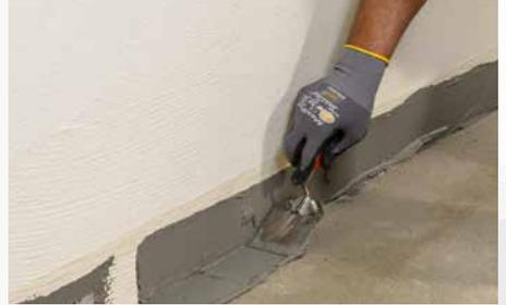
**2** Einstreichen des Sockelbereiches mit einer flexiblen Sopro Dichtschlämme (z. B. Sopro TurboDichtSchlämme 2-K) zur Fixierung ...
