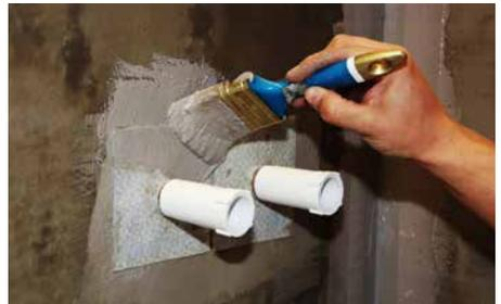
**5** Anschließend die Dichtmanschette in die Dichtungsmasse einbetten.
