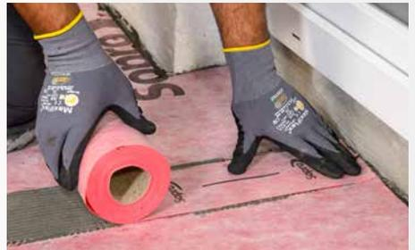
**4** Anschließend wird Sopro AEB® Dichtband in das Kleberbett eingelegt und der Stoßbereich überklebt.
