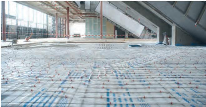
Das Uponor Classic Nassbausystem enthält alle Komponenten, die für eine praxisgerechte Verlegung auf der Baustelle erforderlich sind. Korrosionsgeschützte Trägerelemente und Uponor Classic Rohrhälter bilden die Basis für eine präzise Positionierung des Uponor Comfort Pipe PLUS Heizrohres. Die 0,2 mm dicke, robuste Uponor Multi Folie bietet als Dämmschichtabdeckung gem. DIN 18560 Schutz vor Feuchtigkeit aus dem Estrich.
