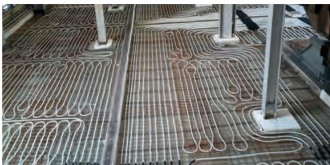
Mit Uponor Magna steht die Wärme dort zur Verfügung, wo sie benötigt wird, nämlich im Bereich bis ca. 2 m oberhalb des beheizten Bodens. Das ist besonders in hohen Hallen von Vorteil, da keine Stauwärme, wie sie von luftgestützten Systemen bekannt ist, entsteht. Somit sind die Wärmeverluste über das Dach wesentlich geringer.
