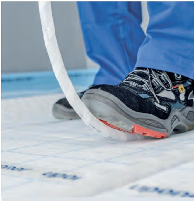
Uponor Klett lässt sich verblüffend schnell und einfach verlegen. Das Rohr wird entweder aus der Hand oder von der praktischen, fahrbaren Uponor Rohrhaspel abgerollt und auf die verlegten Systemplatten aufgelegt. Als Orientierungshilfe für gleichmäßige Rohrabstände dient das aufgedruckte Verlegeraster (10 x 10 cm). Spezielle Verlege- oder Befestigungswerkzeuge werden nicht benötigt.
