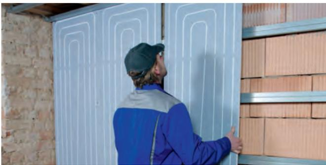
**Die Flächenheizung/-kühlung Uponor Renovis besteht aus einer Gipskartonplatte, in die Uponor PE-Xa Rohre bereits werkseitig integriert sind. Es ermöglicht die Temperierung von Räumen über Wände und Decken in Trockenbauweise. Für die professionelle Anbindung der Panels nach dem Tichelmann-Prinzip steht ein umfangreiches Uponor Sortiment zur Verfügung.**
