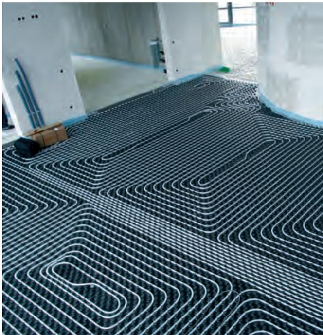
Das Uponor Tecto Nassbausystem kann in der Ein-Mann-Montage verlegt werden. Die Größe der Noppenplatten von 1.450 x 850 mm garantiert eine hohe Verlegeleistung.
