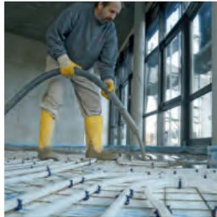
**Uponor Classic Nassbausystem ist das ideale Fußbodenheiz-/kühlssystem für variable Bodenaufbauten im Wohnungsneubau und im gewerblichen Bereich. Drei unterschiedliche Mattenraster ermöglichen die optimale Anpassung der Heizrohrabstände an den jeweiligen Wärmebedarf. In Kombination mit hoch belastbaren Dämmstoffen ist Uponor Classic Nassbausystem auch in Bereichen mit hohen Nutzlasten einsetzbar.**
