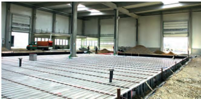
Industrieflächenheizungen sind bauteilintegriert und praktisch wartungsfrei. Zudem sind für die Montage, im Gegensatz zu Deckensystemen, keine Gerüste oder Hubsteiger erforderlich. Selbst auf Verteiler und Sammler kann verzichtet werden, wenn die Abschlussrohrleitungen innerhalb des Industriebodens verlegt werden und der Anschluss der Heizkreise im Tichelmann-Prinzip erfolgt. Hierzu bietet Uponor spezielles Know-how.
