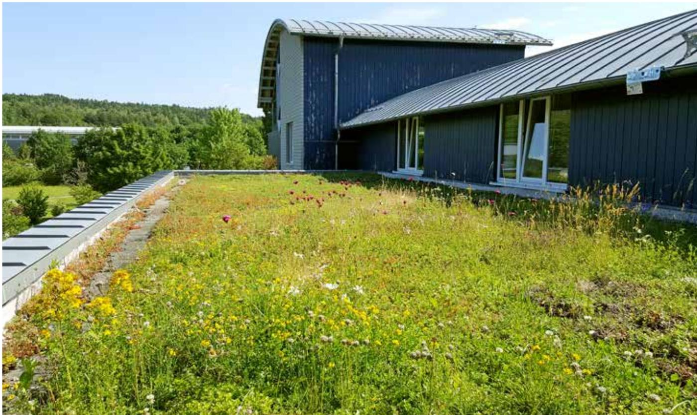
Mit der „Steinrosenflur“ lässt sich eine gestalterisch anspruchsvolle Extensivbegrünung mit individuellem Charakter realisieren. Die Substrathöhe im Systemaufbau liegt bei mind. 7 cm Systemerde „Steinrosenflur“. Die „Steinrosenflur“ kommt vor allem dort zum Einsatz, wo Arten bewusst eingesetzt werden sollen.
