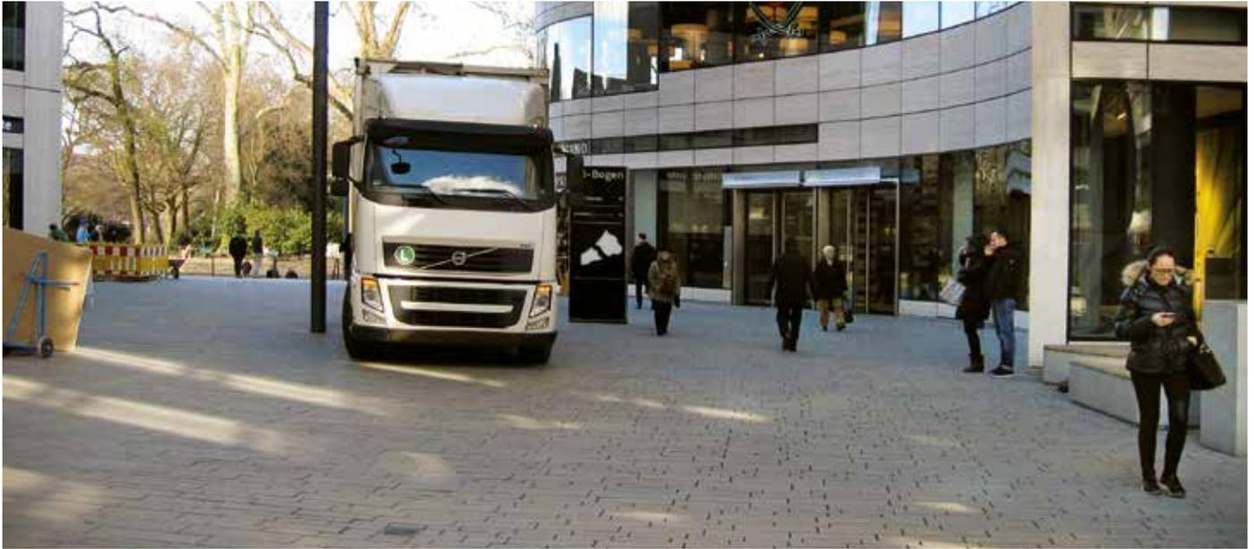
Fahrbeläge auf Dachflächen erfordern nicht nur einen tragfähigen Systemaufbau. Auch Kriterien wie die Tragfähigkeit der Dachkonstruktion oder horizontale Lasten, die durch Bremsen, Lenken und Beschleunigen entstehen, müssen berücksichtigt werden. Die Wahl der richtigen Steindicke und Verlegeart stellt sicher, dass die Pflasterung in ihrer Form erhalten bleibt.
