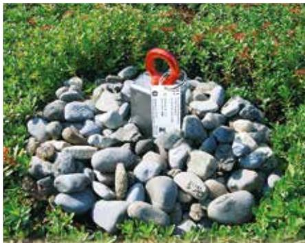
Fallnet® SR (für System Raster) ist ein Einzelanschlagpunkt, an dem eine persönliche Schutzausrüstung befestigt werden kann. Jedes Fallnet® SR wird mit einer Kennzeichnungsplakette am Anschlagpunkt ausgeliefert. Auf dieser finden Sie neben der Produktbezeichnung, der Prüfnorm, dem Herstellungsdatum auch die Seriennummer. Somit lässt sich im Bedarfsfall auch noch nach Jahrzehnten dokumentieren, wie, für welches Objekt und durch wen das Fallnet® SR eingebaut wurde.
