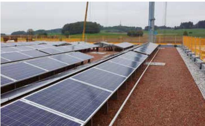
Das oben dargestellte System „SolarVert®“ ist für die klassische Südausrichtung konzipiert, mit einem maximalen Ertrag über die Mittagstunden. Vermehrt werden inzwischen aber auch Systeme mit Ost-West-Ausrichtung realisierbar, um einen gleichmäßigeren Ertrag über den Tagesverlauf zu erzielen und übermäßige Stromspitzen zu vermeiden. Siehe links das Beispiel Stadtwerke Weilheim. Mit der ZinCo-Solarbasis® SB 200 und Grundrahmen mit zum Beispiel 15° Neigung sind derartige Systeme ebenfalls machbar.
