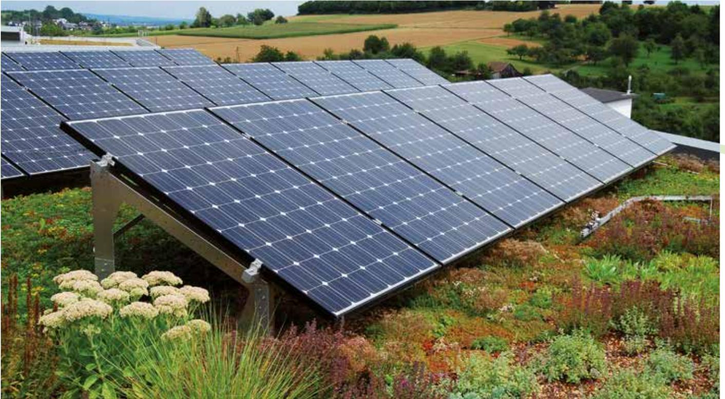
Kombiniert man eine Solaranlage mit einer Dachbegrünung, ergeben sich wichtige Synergieeffekte. Die Vegetationsschicht übernimmt die nötige Auflast zur Windsicherung. Dadurch ist keine Dachdurchdringung nötig und schwere Einzellasten wie Betonklötze entfallen.
