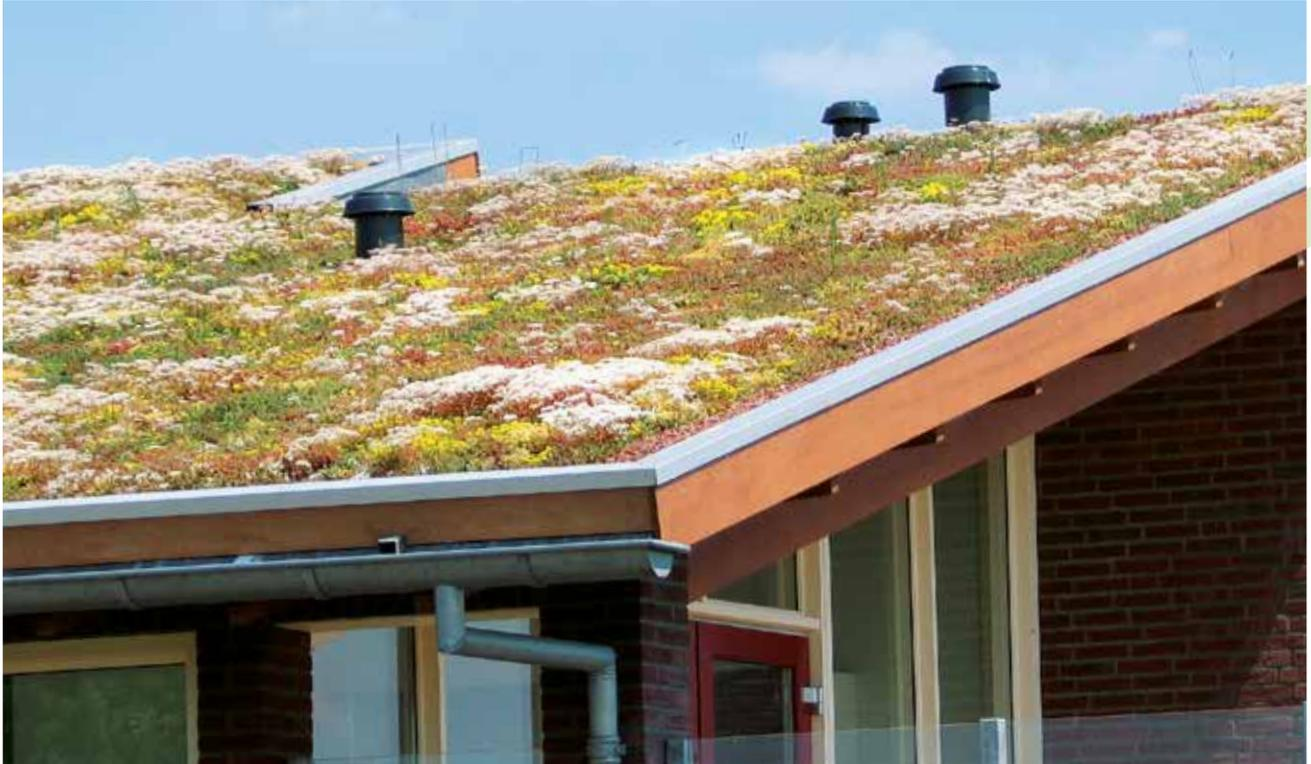
Zwar werden Extensivbegrünungen meist auf Flachdächern aufgebracht, sie sind jedoch genauso auf geneigten Dächern einsetzbar. Ab etwa 10° Neigung muss hierbei jedoch der Schichtaufbau an die veränderten Bedingungen angepasst werden. Zum Einsatz kommen dann schubabtragende Floraset® FS 75-Elemente,
