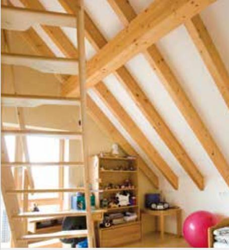
Sofort putz-, streich- bzw. tapezierfähig im Zwischensparrenbereich bei sichtbaren Sparren
