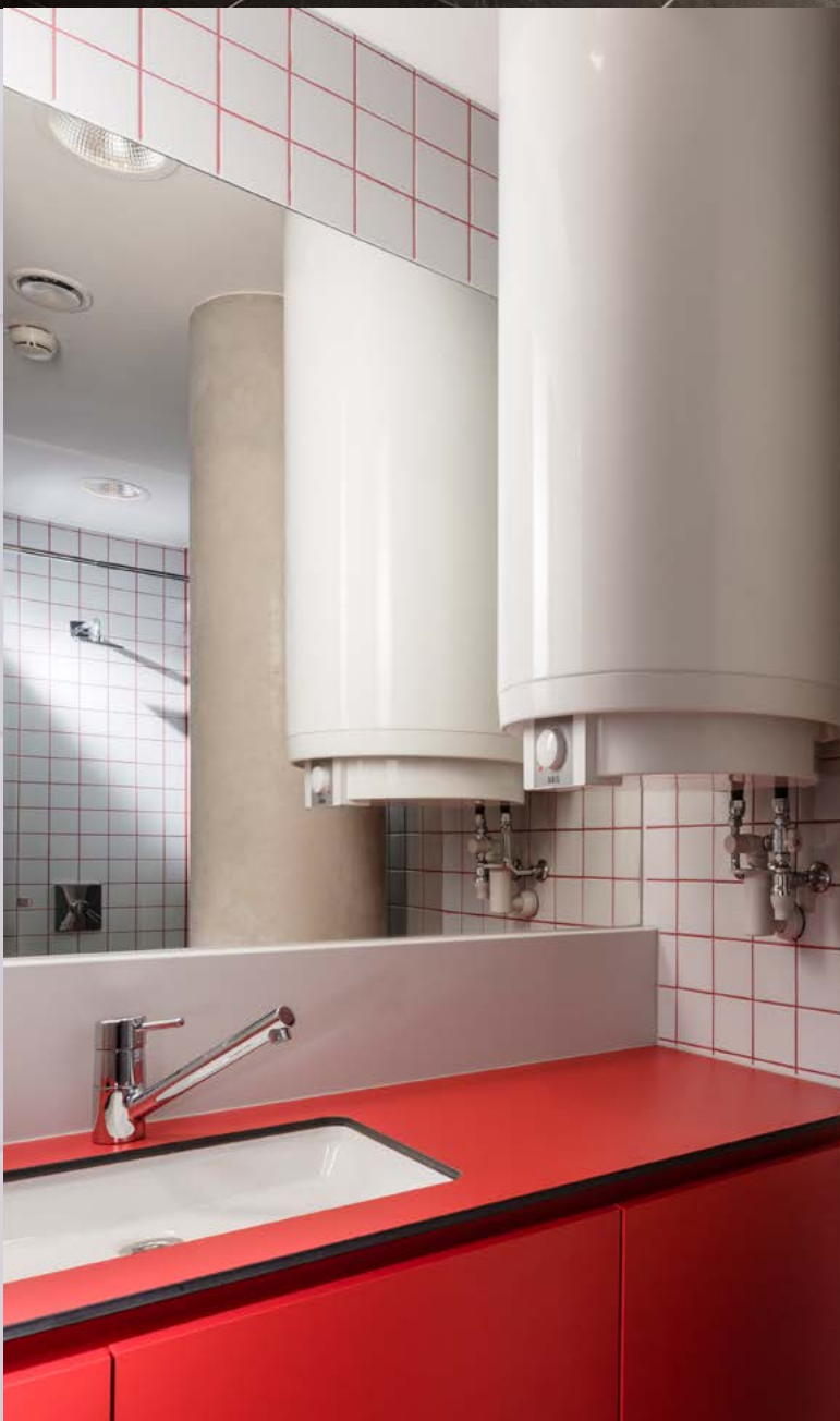
Sanitäre Anlagen in der neuen WAZ-Zentrale Funke Media Office in Essen – AEG Klein-Durchlauf- erhitzer übernehmen die dezentrale Warmwasserversorgung
