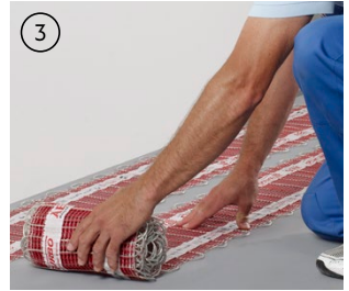
Auslegen der selbstklebenden Heizmatte
