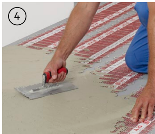
Vollflächiges Abziehen des Klebers auf Heizleiterhöhe
