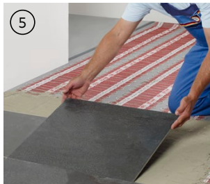
Verlegung der Fliesen
