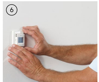
Durchmessen der elektrischen Leitung
