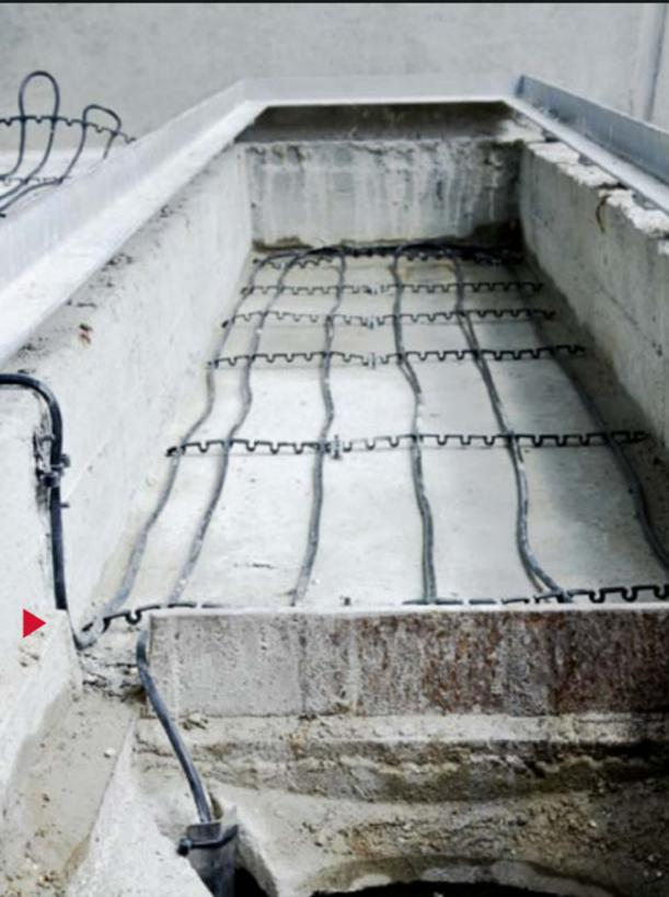
Um in den Rinnen ober- und unterhalb eines Treppenlaufs Eisbildung zu verhindern, wird auch hier das **DIC-Heizkabel** verlegt. Die seitlichen Kehrrinnen werden bei Bedarf ebenfalls beheizt: So kann entstandenes **Tauwasser** ungehindert abfließen.
