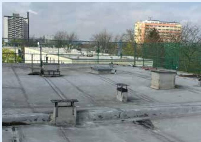
Zahlreiche Mehrfamilienhäuser aus den 50er bis 80er Jahren sind mit einer Schachtlüftung (Kölner Lüftung, Berliner Lüftung etc.) ausgestattet. Über den vorhandenen Schacht und Lüftungsgitter im Bad zum Beispiel erfolgt eine Entlüftung der verbrauchten Luft der Wohnung ins Freie.
