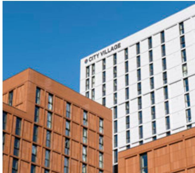
Fassadenkeramik von AGROB BUCHTAL in erdigen Farbtönen verkleidet, die mit den Ziegelgebäuden in dieser Gegend harmonieren. Der Turm ist in hellblau glasierten Platten des gleichen Systems mit glänzender Glasur ausgeführt. Diese hellgetönte Keramik mit ihrer reflektierenden Oberfläche lässt den Turm leichter erscheinen und erhellt ihn gleichermaßen, was für Coventry einen willkommenen zusätzlichen Glanz bedeutet.
