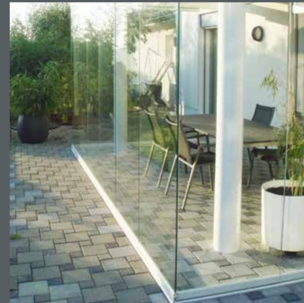
len Durchgang, ohne die gesamte Anlage bewegen zu müssen. Die weiteren Flügel lassen sich flexibel verschieben, können in beliebiger Position verbleiben oder an der vorgesehenen Parkposition komplett herausgedreht werden. So entsteht ein System, das je nach Bedarf ganz oder teilweise geöffnet werden kann.
