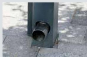
TerraLinea mit in die Stützen integriertem Fallrohr.
