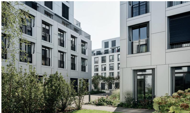
„In Bezug auf die Leichtigkeit, Materialeffizienz sowie die Robustheit stellen Aluminiumoberflächen sehr nachhaltige Fassadensysteme dar. Durch den hohen Vorfertigungsgrad lassen sich die ALUCOBOND®-Paneele präzise im Realisierungsablauf terminieren und nach Bedarf des Objekts mit fortschreitendem Bauprozess montieren.“
