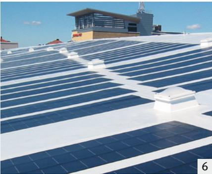
EVALON® Solar, die weltweit erste Kunststoffdachbahn mit integrierten flexiblen Photovoltaikmodulen, ist das Ergebnis eigener Forschungs- und Entwicklungsarbeit – für eine ökologisch wie ökonomisch effiziente Stromgewinnung.
