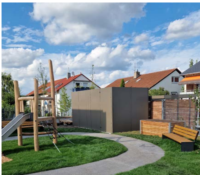
Schallschutzwand für Bauvorhaben Kita in Fellbach Wärmepumpe mit 70 kW und Schallleistungspegel 82 dB(A)
