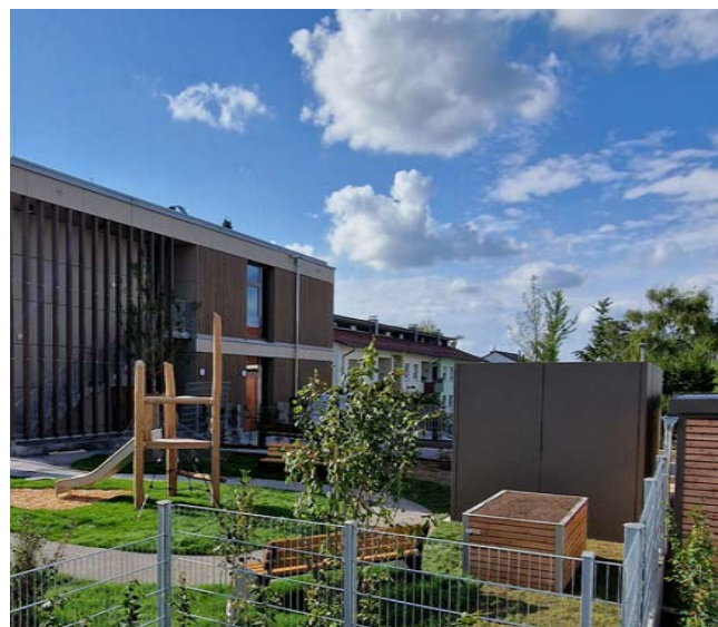
Schallschutzwand für Bauvorhaben Kita in Fellbach Wärmepumpe mit 70 kW und Schallleistungspegel 82 dB(A)
