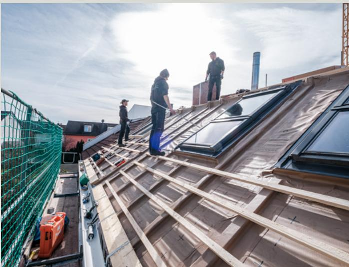
wird gemäß der von Autarq erstellten Soll-Belegungspläne entlang der Dachlatten verlegt. Diese Aufgabe übernehmen die Dachhandwerksbetriebe, unterstützt und angeleitet von einem Autarq-Lehrverleger, oder im Falle ihrer bestehenden Zertifizierung als Next-Level-Roofer-Betrieb, komplett eigenständig.
