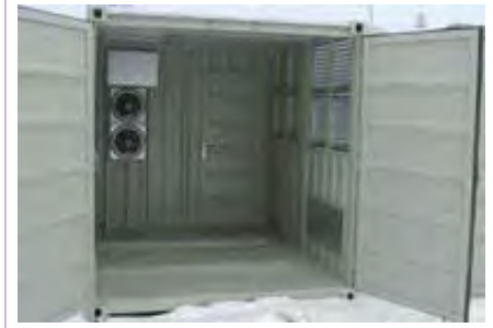
Technikstahlcontainer mit Isolierung und Innenverkleidung Lochblech
