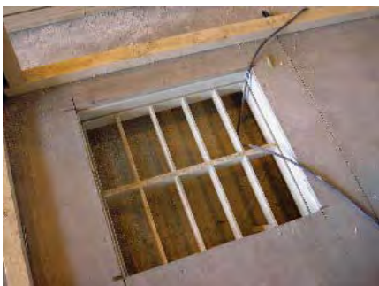
Roxtec Rahmen im Boden eingeschweißt
