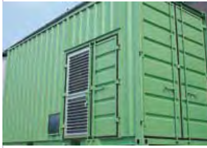
Partielle Schallisolierung mit Lochblech und Schallkulissen vor der Abluftöffnung
