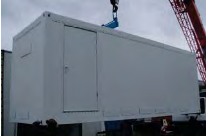
Detaillierte Vorbereitung für bauseitige Klimaanlage und versenkte Montageschienen für diverse Anbauten
