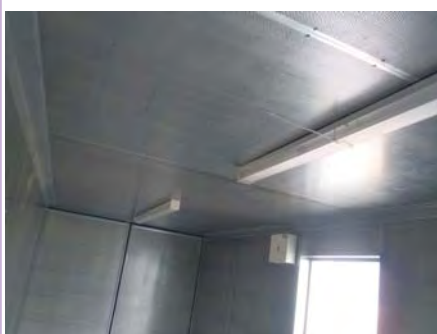
Decke und Wände mit Lochblechverkleidung
