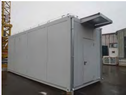
Sandwichpaneele - Ansicht außen Vordach, Regenentwässerung, Blitzschutz
