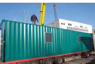
Seite 13 umgebauter 12 m Seecontainer
