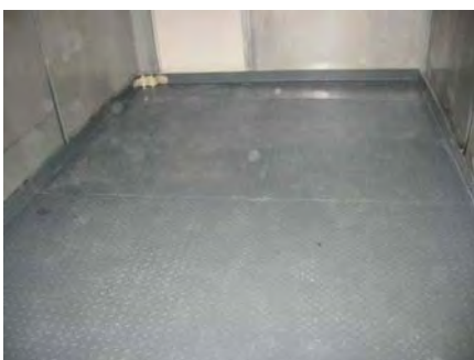
Öldicht verschweißte Bodenwanne
