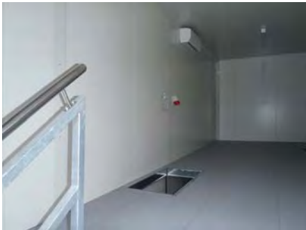
Wandpaneele mit Blechverkleidung innen, MERO Doppelboden und Innentreppe
