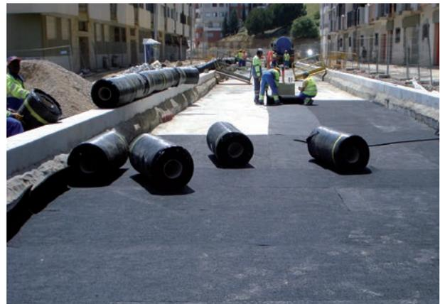
Die Verlegung von **Regupol® SB 16/100<sup>prof</sup>**, eine bewährte elastische Zwischenschicht für leichte Masse-Feder-Systeme, in Almada, Portugal.
