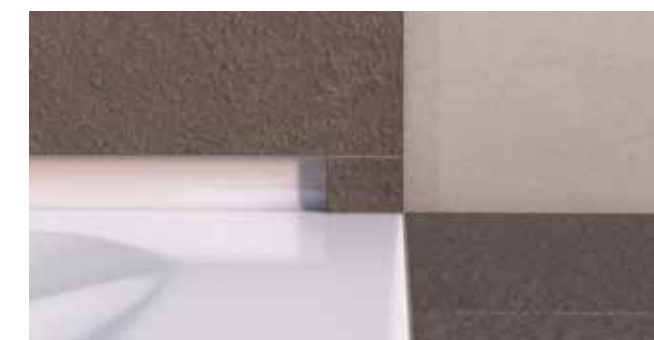
Ein kleines Fliesenstück wird hinter der Duschabtrennung aufgesetzt, um den Hohlraum zu schließen
