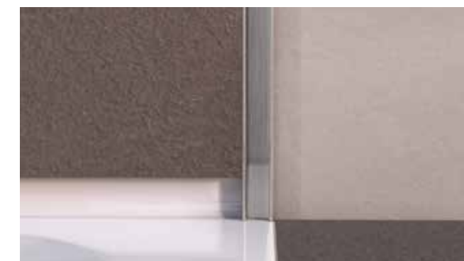
U-Profil wird von den Fliesen eingefasst
