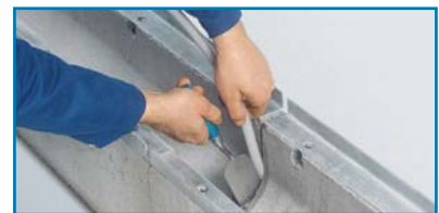
3. Einbringen der PE-Dichtschnur
