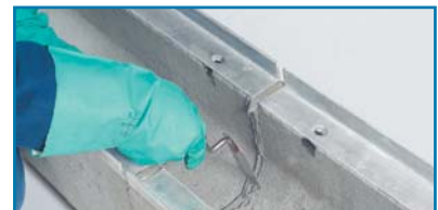
6. Glätten der Fugenoberfläche
