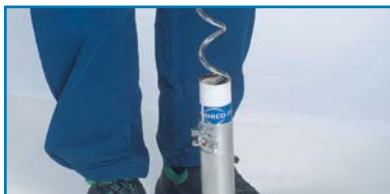
4. Mischen des Fugendichtstoffes
