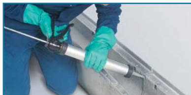
5. Einbringen des Fugendichtstoffes
