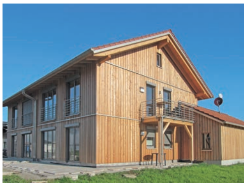
Doppelhaus in Holzbauweise
