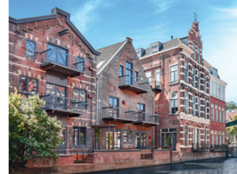
Hotel Pakasa in Leiden, Sanierung im Denkmalschutz
