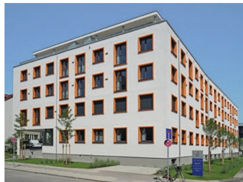
Förderzentrum München Giesing
