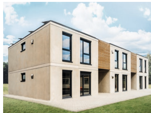
Modulbau Sozialwohnungen in Schöppingen
