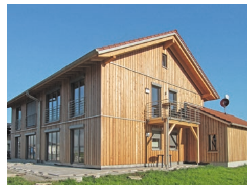
Doppelhaus in Holzbauweise
