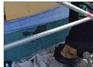
6. Auf der durchgetrockneten Kratzspachtelung vollflächig RD 2 mit einem Zahnlätter aufziehen.
