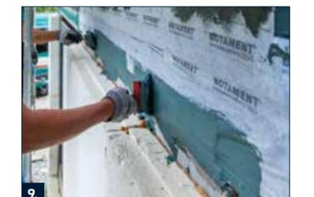
9. PB Portalichtbands faltenfrei in die frische Abdichtung aus RD 2 einbetten und den Übergang großzügig mit RD 2 überarbeiten.
