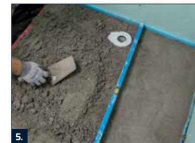
5. Auf Ölpapier oder PE-Folie Estrich aus M 5/4 FM Schnellestrich-Fertigmörtel waagrecht in der gewünschten Höhe erstellen.
