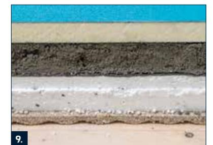
9. Fußbodenaufbau mit optimaler Schalldämmung und maximalem Komfort mit begehbaren, bodengleichen Duschen
