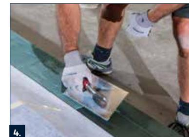
4. Auf der durchgetrockneten Kratzspachtelung RD 2 mit einem Zahnlätter vollflächig auftragen.
