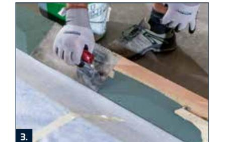
3. PB Portalichtband umschlagen und Kratzspachtelung aus RD 2 auftragen.
