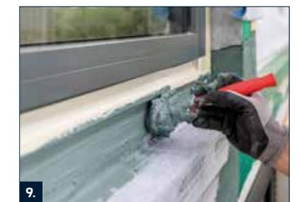
9. Um eine Hinterläufigkeit der Dichtbänder zu vermeiden, mindestens die Enden des PB Portaldichtbandes mit RD 2 überarbeiten.
