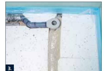
3. Auf der Schallschutzmatte TE Plus die Wärmedämmung als Ebene für die Installationen einbauen. Zur Vermeidung von Schallbrücken an den Wänden auf der Schallschutzmatte Randdämmstreifen vorsehen.
