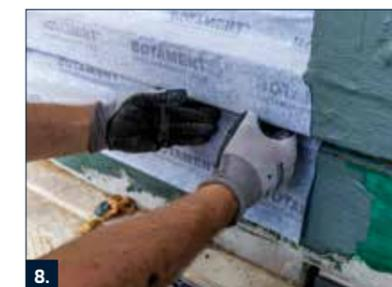
8. PB Portaldichtband faltenfrei in die frische Abdichtung aus RD 2 einlegen. Im Bereich von Fugen, bei denen mit größeren Bewegungen zu rechnen ist, PB Portaldichtband spannungsfrei und möglichst schlaufenförmig einbetten.
