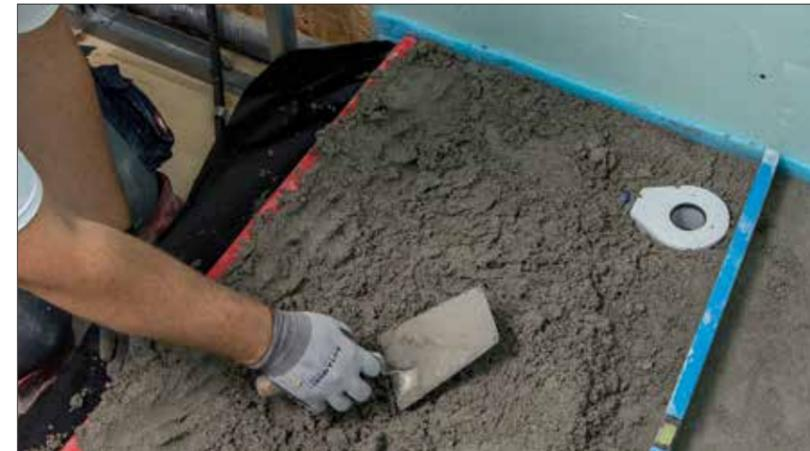
Begehbare, bodengleiche Duschen können im Holzbau aufgrund der guten Schallübertragung der Holz-Rohdecke aufwändige Konstruktionen erfordern, wenn Anforderungen an den Schallschutz gestellt werden. Eine besonders einfache Lösung bietet das Duschboard LD in Kombination mit der Schallschutzmatte TE Plus.
