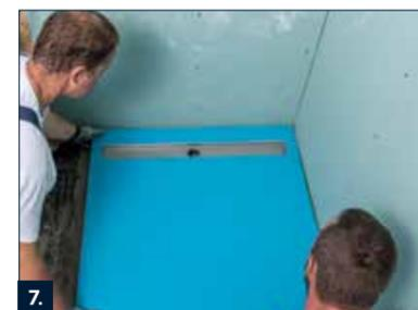
7. LD Duschboard mit Linientwässerung, vorgefertigtem Gefälle und ab Werk erstellter Abdichtung in den frischen Estrich einbetten und in Höhe und Richtung ausrichten.
