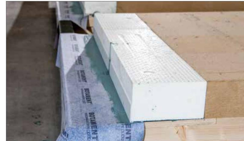
Eine Teilvorfertigung der Sockelabdichtung in der Elementhalle bietet viele Vorteile gegenüber einer reinen Baustellenmontage. Zum einen kann die Abdichtung unter gleichbleibenden klimatischen Bedingungen und geschützt vor Wind, Regen und hohen oder tiefen Temperaturen ausgeführt werden. Zum anderen lassen sich auch nachfolgende Arbeitsschritte, wie etwa das Anbringen der Sockeldämmung, bereits in der Halle sauber ausführen.
