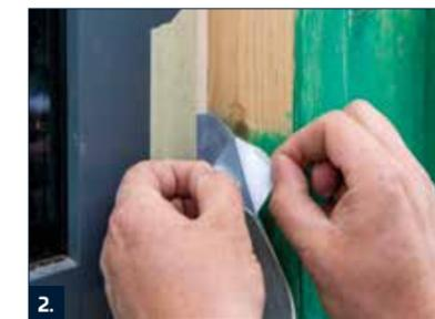
2. Bietet die Einbausituation nur wenig Platz, kann mit BD Butyldichtband der Abdichtungsanschluss bis 15 cm über der Geländeoberkante hergestellt werden. Butyldichtbänder vollflächig mit RD 2 überarbeiten.
