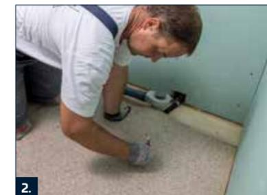
2. Auf der Holzdecke die TE Plus Schallschutzmatte vollflächig unter den Installationsrohren einbauen.
