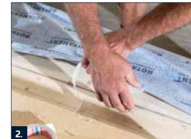
2. PB Portalichtband am Wandelement mit dem Klebestreifen fixieren.
