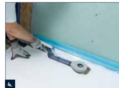
4. Auf der Installationsebene die Trittschalldämmung verlegen.
