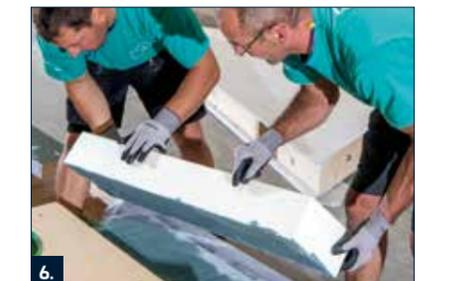
6. Die zugeschnittene Sockeldämmplatte mit RD 2 im Buttering-Floating-Verfahren vollflächig auf dem PB Portalichtband verkleben.
