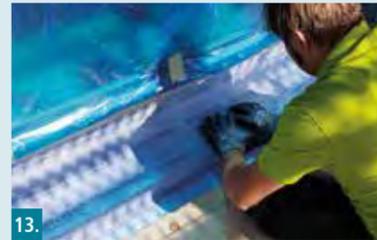
13. PB Portaldichtband faltenfrei in die frische Abdichtung einbetten.
