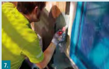
7. BD Butyldichtband vollflächig mit RD 2 überarbeiten.
