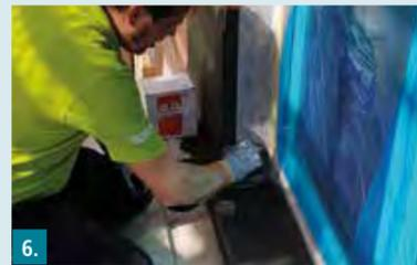
6. Übergänge von der Leibung zum Fensterelement ggf. mit BD Butyldichtband abdichten.
