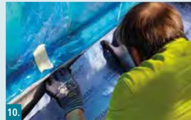
10. PB Portaldichtband mit Fixierstreifen am Fensterelement anbringen.
