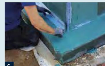
6. SB 78 in Innenecken faltenfrei in die erste Abdichtungslage einbetten. Stöße zu anderen Dichtbändern mindestens 5 cm überlappen.
