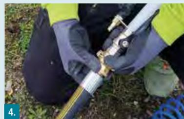
4. Mörtelschlauch und Spritzkopf verbinden.
