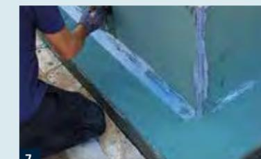
7. Die Stege des frischen RD 2 glätten. Dabei die Übergangsbereiche von der Flächenabdichtung zum Dichtband überarbeiten. Dehnzone in der Innenecke frei lassen.
