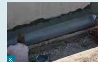
8. Auf der durchgetrockneten Kratzspachtelung RD 1 | RD 2 auftragen. GS 98 Glasfasergewebe in die erste Abdichtungslage einbetten. Auf der Bodenplatte die Abdichtung mindestens 10 cm auf der Stirnseite herabführen.
