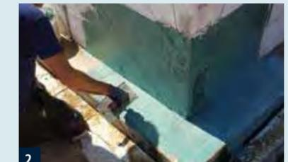
2. Kratzspachtelung zum Verschluss von Poren und Lunkern aus RD 2 auftragen. Überschüssiges Material vom Untergrund entfernen.
