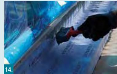
14. Übergänge vom PB Portaldichtband zu anderen Bauteilen mit RD 2 überarbeiten.
