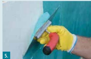
**5.** Zur Verbesserung der Haftung und zum Schließen von Poren und Lunkern RD 1 | RD 2 mit der glatten Seite eines Glätters auf den Untergrund aufkratzen (Kratzspachtelung).
