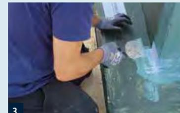
3. RD 2 mit Flächenstreicher oder Glätter auf der durchgetrockneten Kratzspachtelung auftragen und an Ecken SB 78 Innen- bzw. Außenecken einlegen.
