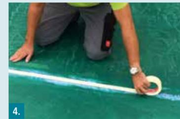
**4.** Dehnzonen in den Dichtbändern mit Klebeband abdecken.
