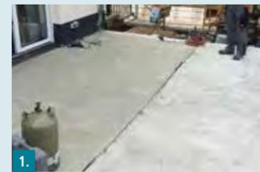
**1.** Untergrund auf Tragfähigkeit und Gefälle prüfen. Ggf. lose Bestandteile entfernen oder Gefälle mit M 35 Multimörtel oder M 54 FM Schnellstreich herstellen.
