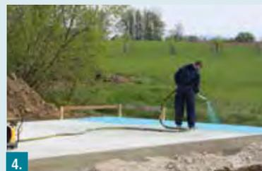
4. In der Regel kann bei maschineller Verarbeitung auf eine Kratzspachtelung verzichtet werden. Bei ungünstigen Untergründen kommt es nach kurzer Zeit zur Blasenbildung. In diesem Fall muss die übrige Fläche jedoch mit einer Kratzspachtelung versehen werden.
