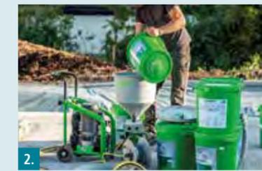
**2.** Besonders effektiv ist die Kellerabdichtung im Spritzverfahren, wenn die Maschine auf der Decke des Kellers platziert wird. Ohne störende Erdgeschosswände können alle abzudichtenden Flächen erreicht werden, ohne dass die Maschine versetzt werden muss.
