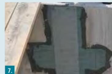
7. Auf der durchgetrockneten Kratzspachtelung RD 1 | RD 2 auftragen. GS 98 Glasfasergewebe in die erste Abdichtungslage einbetten. Fugen mindestens 15 cm auf beiden Seiten überlappen.
