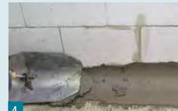
4. Hohlkehle mit einem Hohlkehlschlitten mit einem Radius von 4-6 cm formen. Ggf. Übergangsbereich von Hohlkehle zu den angrenzenden Bauteilen mit einem Flächenstreicher verschleifen.
