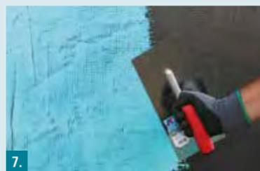
**7.** Nicht mineralische Untergründe wie Metall oder alte Bitumenabdichtungen säubern. Kratzspachtelung auf dem trockenen Untergrund auftragen.
