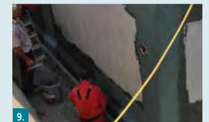
9. Nach Durchtrocknung der ersten Abdichtungsschicht eine zweite Lage ohne Gewebeeinlage einbauen.
