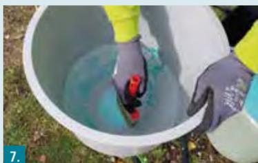
7. Mörtelbehälter mit geeignetem Werkzeug reinigen.
