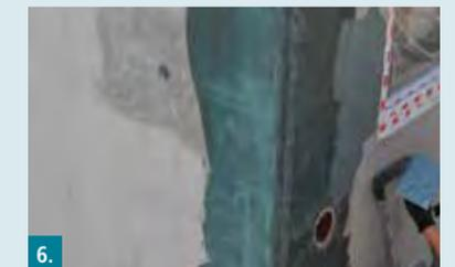
6. Abzudichtende Flächen mit einer Kratzspachtelung aus RD 1 | RD 2 versehen. Überschüssiges Material entfernen.
