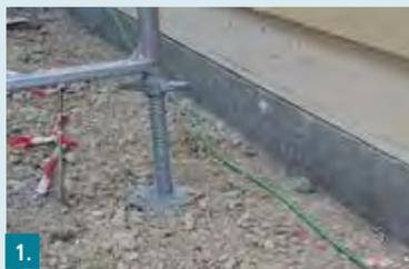
**1.** Die Abdichtung muss die Fuge zwischen Betonplatte und Holzkonstruktion dauerhaft überbrücken.
