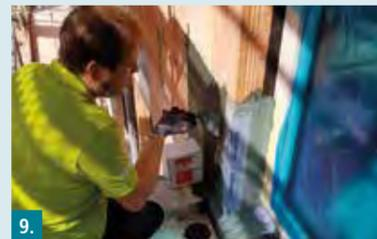
9. An nicht gefasteten Kanten SB 78 Systemdichtband faltenfrei in RD 2 einbetten.
