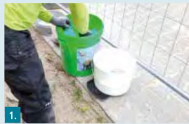
**1.** Zum Anmischen von RD 2 die Pulverkomponente in die Flüssigkomponente schütten. Bei der Entnahme von Teilmengen zuerst die Flüssigkomponente in einen sauberen Eimer geben.
