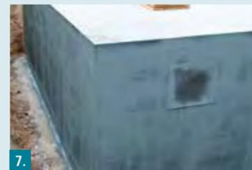
**7.** Die Schichtdicke wird über Schichtdickenmessungen und über den Materialverbrauch bestimmt. Mörtelschläuche und Förderpumpe sollten je nach Witterung nach 5-8 Gebinden mit Wasser und Schwammkugel gereinigt werden.
