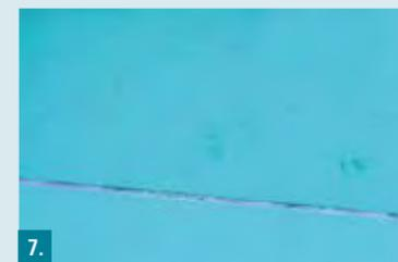
**7.** Klebebänder auf den Dichtbändern im frischen Zustand entfernen. Dehnzone bleibt sichtbar.
