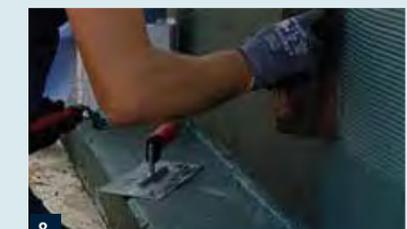
8. Nach Durchtrocknen der Abdichtungsschicht zweite Lage auftragen. Stege glätten.
