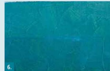
**6.** Erste Abdichtungslage erst aufbringen wenn ein deutlicher Farbumschlag erfolgt ist und die Kratzspachtelung erhärtet ist.
