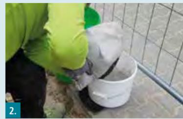
**2.** Pulverkomponente in die Flüssigkomponente geben. Teilmengen abwiegen. Die Waage muss dabei auf einem festen Untergrund stehen.
