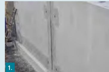
1. Zementschleier auf der Bodenplatte und in Fugenrandbereichen entfernen.
