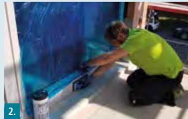
2. Fensterelemente mit Gitterschleifer oder Schleifpapier anrauen.
