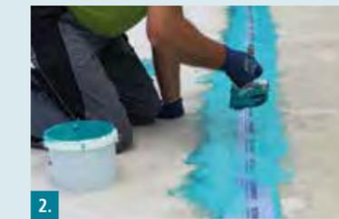
**2.** Fugen und Ecken mit SB 78 Systemdichtband und PB Portalichtband abdichten.
