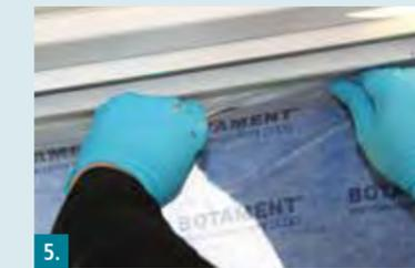
5. Zugeschnittenes Portalichtband mit dem Klebestreifen am Fensterahmen fixieren.
