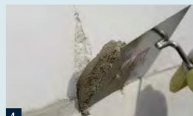
4. Fehlstellen > 5 mm mit M 35 oder M 36 Speed verschließen. Offene Fugen und Fehlstellen ≤ 5 mm mit RD 1 und RD 2 während der Kratzspachtelung füllen.
