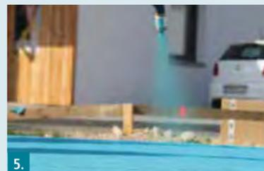
5. Nach Durchtrocknen der ersten Abdichtungslage wird die zweite Abdichtungsschicht ebenfalls im Kreuzgang aufgetragen.
