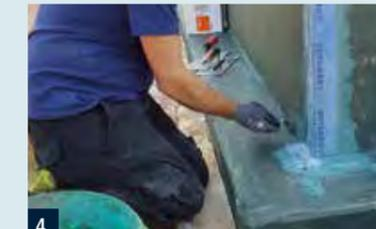
4. An nicht gefasteten Außenecken SB 78 in RD 2 einlegen und faltenfrei einbetten.
