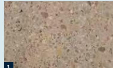
3. Staub und Schleierrückstände entfernen. Betonuntergründe sind i.d.R. tragfähig wenn der Zementschleier soweit abgetragen ist, dass die Zuschlagkörner sichtbar sind.
