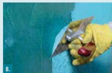
**8.** Erste Abdichtungslage auf der trockenen Kratzspachtelung auftragen. Um einen gleichmäßigen Materialauftrag bzw. Schichtstärke der Abdichtung zu gewährleisten Zahnglätter verwenden.
