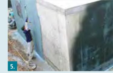
**5.** Abstand des Spritzkopfes vom Untergrund von etwa 20 bis 30 cm. I.d.R. kann bei maschineller Verarbeitung auf eine Kratzspachtelung verzichtet werden. Ungünstige Untergründe bilden bereits nach kurzer Zeit Blasen. In diesem Fall ist jedoch eine Kratzspachtelung erforderlich.
