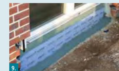
9. Übergänge vom PB Portalichtband zur vorhandenen Bauwerksabdichtung und zum Fensterelement mit einem Quast oder Pinsel großzügig überarbeiten.
