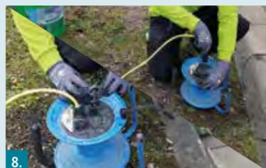
8. Kompressor und Förderpumpe vom Strom trennen.
