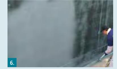
**6.** Grundsätzlich im Kreuzgang spritzen. Bei der Wassereinwirkungsklasse W1-E kann die zweite Abdichtungslage frisch in frisch aufgebracht werden.
