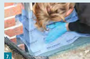
7. Portalichtband in die frische Reaktivabdichtung einbetten.
