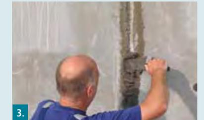
3. Fugen mit M 36 Speed verschließen.
