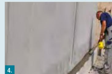
4. Mörtelhohlkehle aus M 36 Speed einbauen. Alternativ Innenecke mit SB 78 Systemdichtband und RD 2 ausführen.
