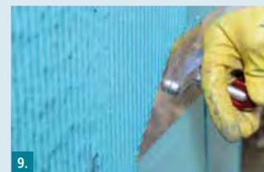
**9.** Stege im frischen Zustand glätten ohne Material wieder abzutragen. Auf der durchgetrockneten ersten Abdichtungsschicht die zweite Lage in der gleiche Arbeitsweise aufbringen.
