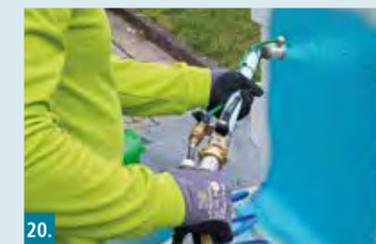
20. Spritzbild über Pumpleistung und Ansaugleistung des Kompressors einstellen. Die Förderleistung der Pumpe sollte zwischen 0,5 und 1,3 bar liegen.
