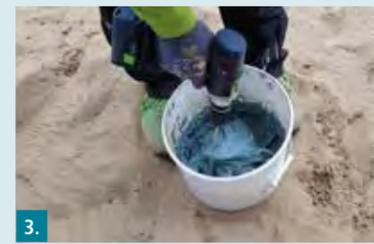
**3.** Pulver und Flüssigkeit maschinell mindestens 2 min verrühren (Empfehlung: Rührpaddel). RD 1 ist gebrauchsfertig und braucht nicht angemischt zu werden. Die Entnahme von Teilmengen vereinfacht sich dadurch.
