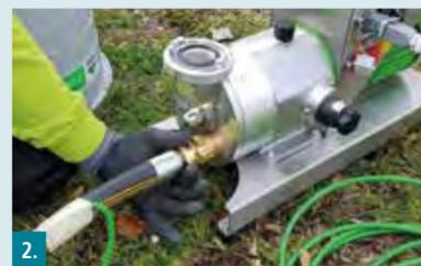
2. Mörtelschlauch anschließen und handfest verschrauben.
