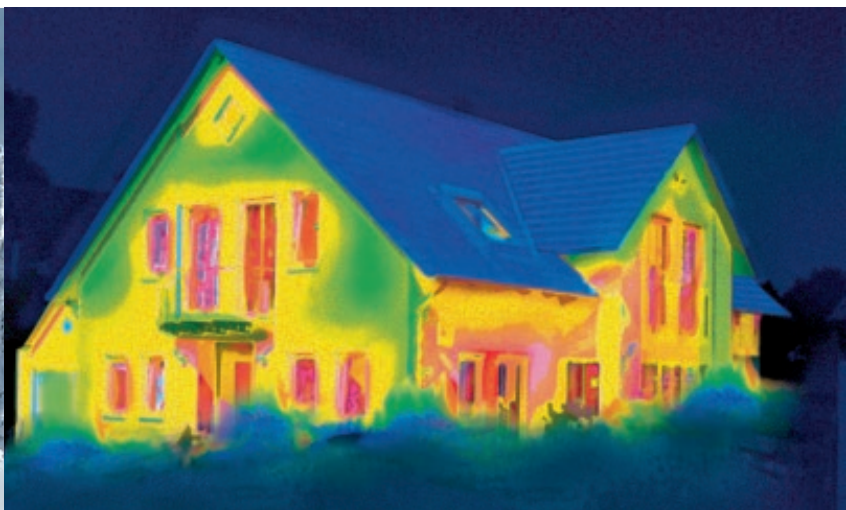
Dieses Dach ist gut gedämmt. Im Gegensatz zu den Wänden.
