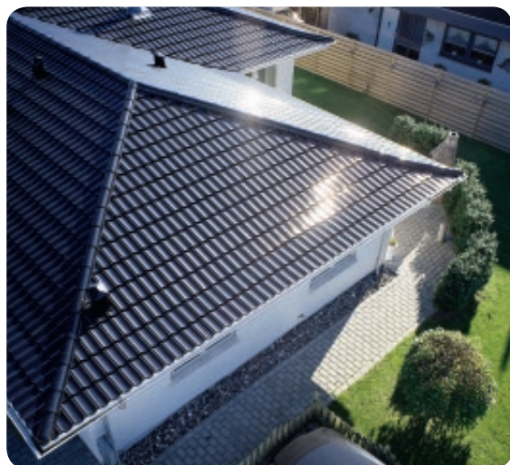
Eindeckung mit Metallplatten.
