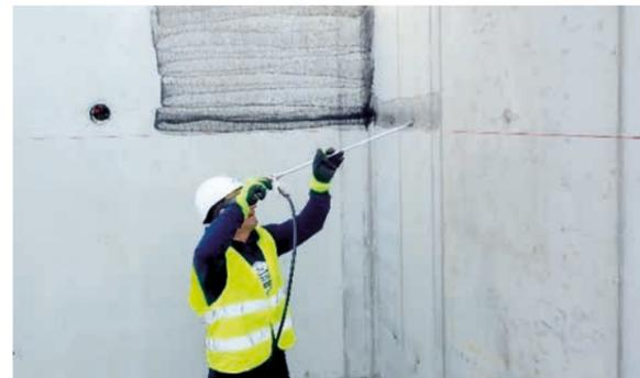
AUFSPRÜHEN VON FG 35 AUF DIE BETONOBERFLÄCHE
