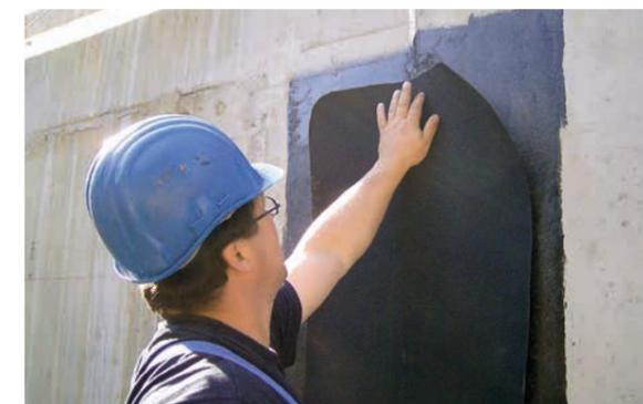
Bewegungsfugen in der Bodenplatte oder Wand können bei W1-E mit dem Bewegungsfugenband RESIFLEX® SK ausgeführt werden. Den Untergrund entsprechend der Verarbeitungsrichtlinien vorbereiten und im Anschluss RESIFLEX® aufbringen. Danach werden die Ränder mit dem Untergrund verschweißt.
