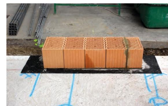
RESITRIX® CL kann auch zusätzlich auf der ersten Steinreihe verlegt werden, um aufsteigendes Wasser während der Bauphase oder bei Wasserschäden zu verhindern.
