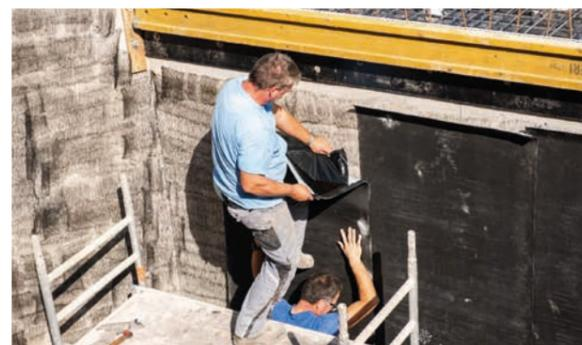
ANSETZEN UND AUSRICHTEN DER BAHN
