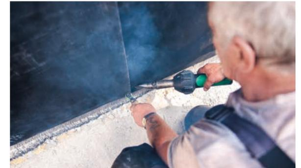
VERSCHWEISSEN DER BAHNEN MIT EINEM HEISSLUFTFÖN
