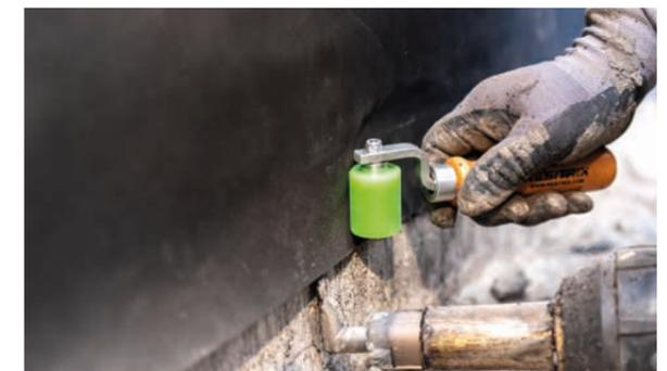
ANSCHLUSS AN BODENPLATTE MIT WINKELDÜSE
