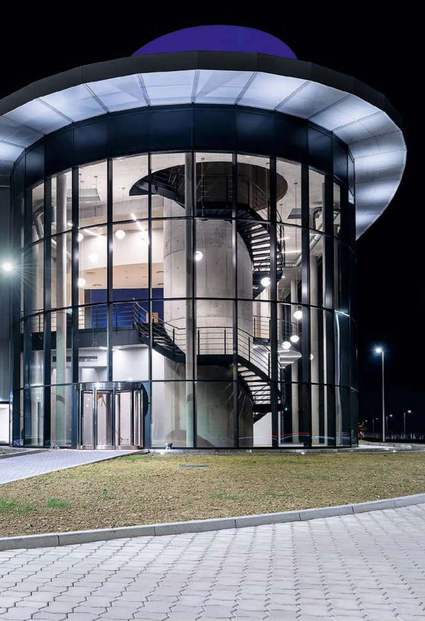
Markanter Blickfang des Neubaus ist die ellipsenförmig geschwungene, dabei großzügig verglaste Front zur Straße. Vom Innenraum aus bietet sich dort eine weite Aussicht auf die Umgebung.
