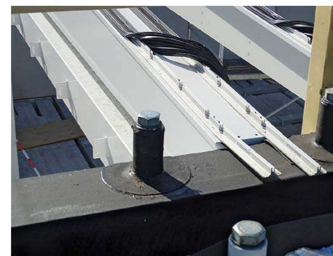
Für einen effektiven Schutz gegen Feuchtigkeit wurden die Dachflächen mit HERTALAN® EASY COVER EPDM-Planen abgedichtet.
