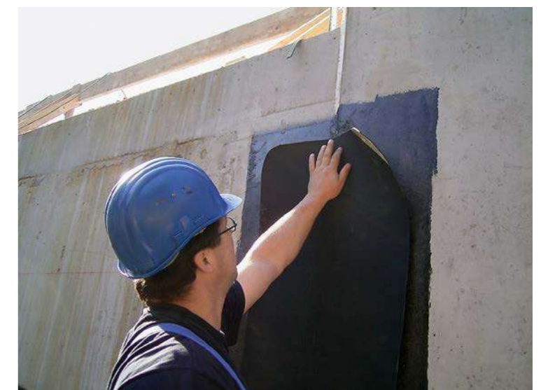
Selbst Arbeitsfugen innerhalb einer WU-Betonkonstruktion können mit dem Multitalent RESITRIX® SK W Full Bond einfach und sicher abgedichtet werden.
