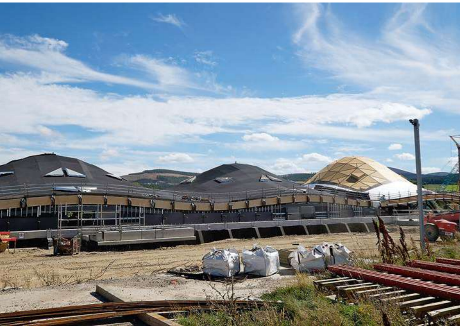
Auf dem 12.300 m 2 großen Kuppeldach wurden RESITRIX® SK W Full Bond EPDM-Dichtungsbahnen verlegt. Die unterseitige, selbstklebende Polymerbitumenschicht sorgt dafür, dass auch an den 20 bis 45 Grad geneigten Kuppelflanken nichts verrutscht.
