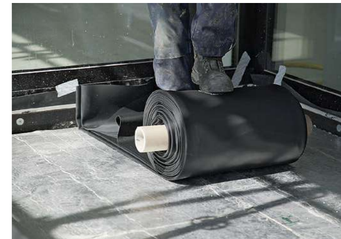
Vor Ort wurden alle Loggien erst nach der Montage vermessen, die Planen zugeschnitten und ausgelegt – so konnte eine höchste Detailgenauigkeit gewährleistet werden.
