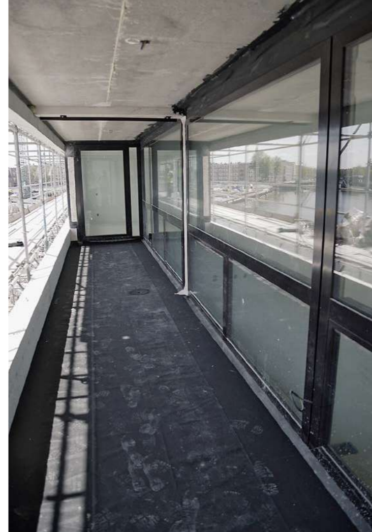
Jede der 318 Loggien im Pontsteiger wurde mit HERTALAN® EASY COVER EPDM-Dichtungsplanen wasser-, luft- und winddicht abgedichtet.
