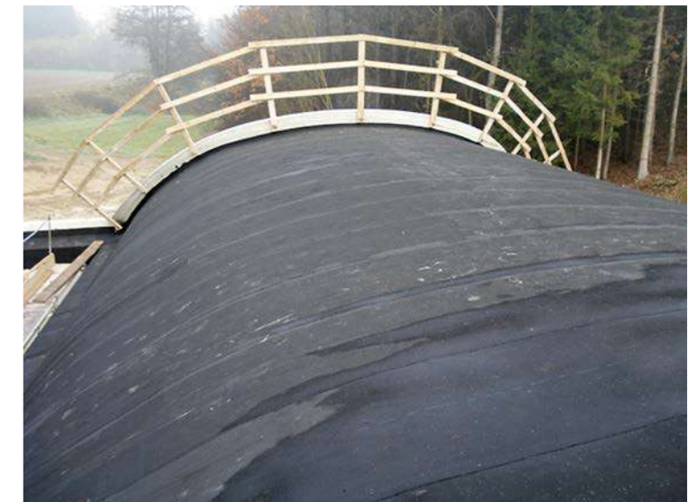
Hält einiges aus: Selbst stark befahrene Flächen werden mit RESITRIX® SK W Full Bond dauerhaft sicher abgedichtet. Hier schützt die EPDM-Bahn eine erdüberschüttete Bogenbrücke im Autobahnbereich.
