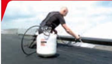
Verlegen ohne offene Flamme: eine Forderung, die wir bei unseren Verlege-Techniken berücksichtigt haben. Die HERTALAN® Nahtfügetechnik wird über einen werkseitig vorkonfektionierten EW-Fügerand mittels Heißlufttechnik ausgeführt. Eine austretende Schweißraupe signalisiert eine optimale und dauerhaft sichere Nahtverbindung. Alternativ ist aber auch eine Nahtfügung über eine Verklebung möglich.
