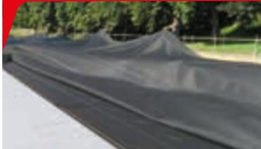
HERTALAN® EASY COVER bildet einen Maßanzug für Ihr Flachdach. Mit diesen EPDM-Planen können dauerhaft dichte Abdichtungen einfach, schnell und sicher hergestellt werden. Außerdem wird die Anzahl manuell zu erstellender Nahtverbindungen auf der Baustelle und damit die Gefahr undichter Stellen auf ein absolutes Minimum begrenzt. Hierbei können durchaus großformatige EPDM-Planen gefertigt werden.
