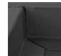
Gehrungsschnitt im Bereich der Dachfläche durchführen und anschließend den zweiten Anschlussstreifen verschweißen.
