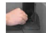
Schutzfolie im Bereich der Quetschfalte entfernen und diese mit Heißluft verschweißen. Quetschfalte mittels Bitumenabstrich an der Attika fixieren.
