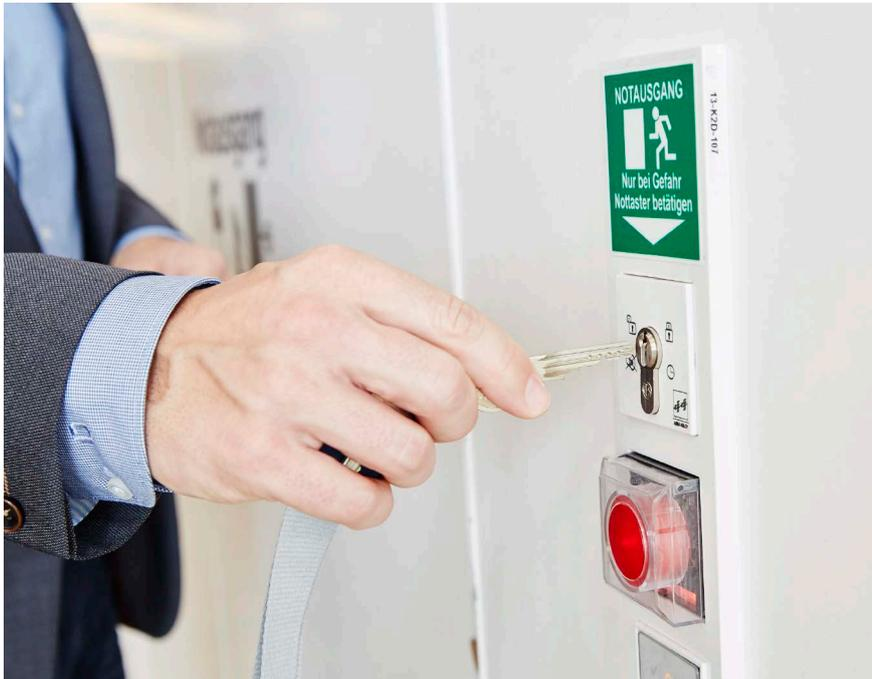
Integriert in die FTS-Terminals ermöglichen die Schlüsselschalter eine Daueröffnung der Tür
