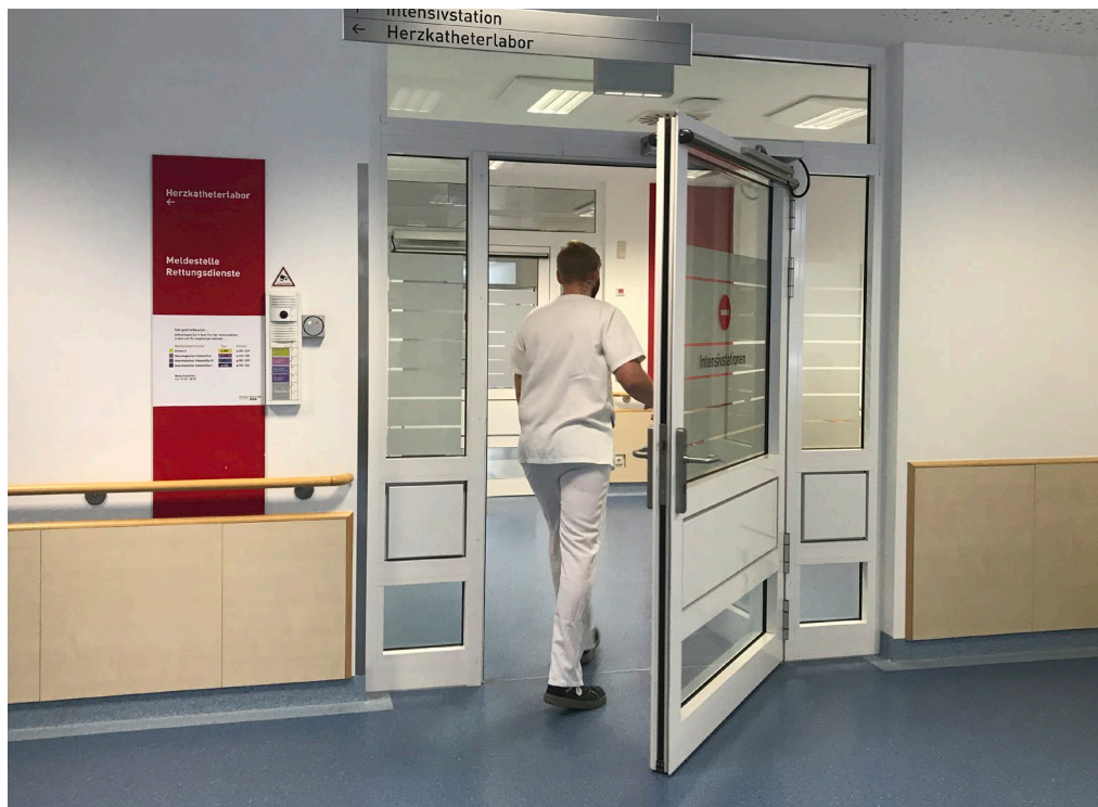
In den Kliniken Maria Hilf kommt das CES OMEGA FLEX System überall zum Einsatz, wo erhöhte Sicherheitsanforderungen gelten und individuelle Zutrittsregelungen erforderlich sind.
