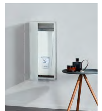
Hinter einer Revisionsklappe
