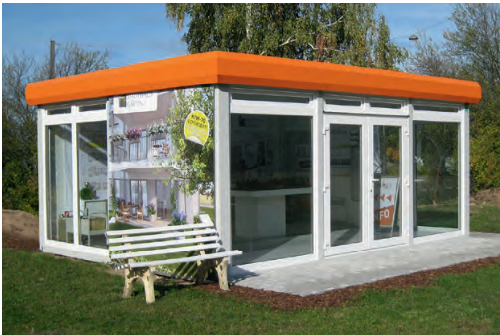
Doppelanlage als Schauraum
