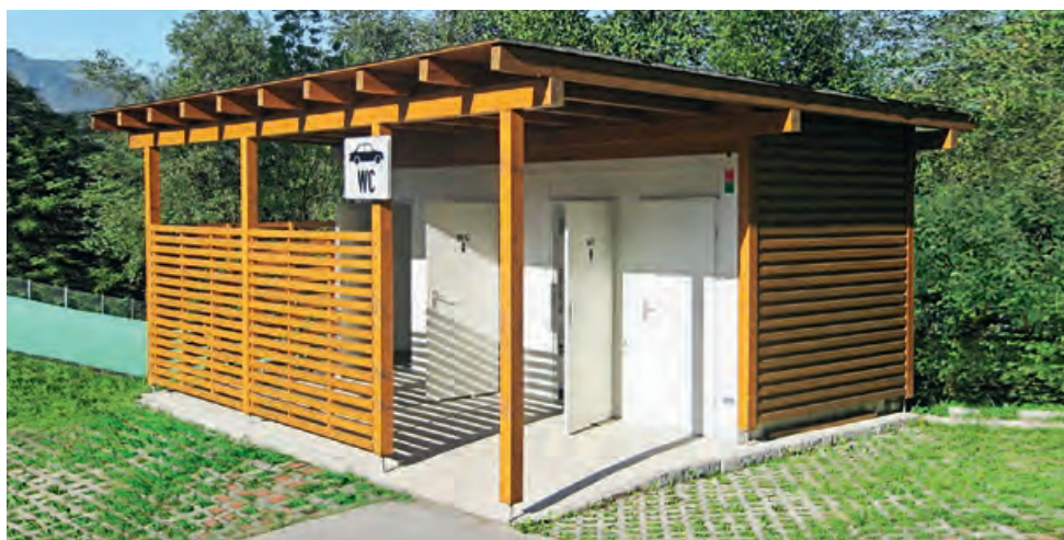
20' WC-Container als Parkplatztoilette adaptiert
