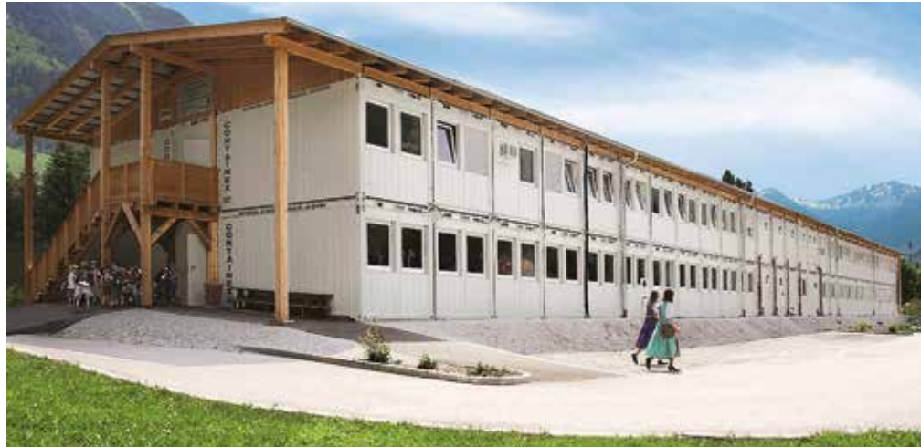
Schule zweistöckig mit Sekundärdach
