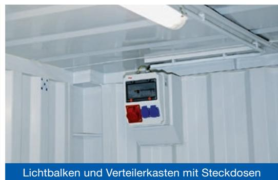
Lichtbalken und Verteilerkasten mit Steckdosen
