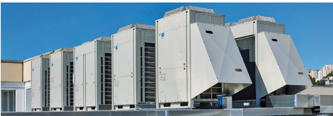
Sechs Maschinen übernehmen mit einer Kälteleistung von insgesamt 58,8 kW die Tiefkühlung in drei Tiefkühlräumen, den Normalkühlbetrieb gewährleisten 22 ZEAS mit einer Gesamtkälteleistung von 461 kW.
