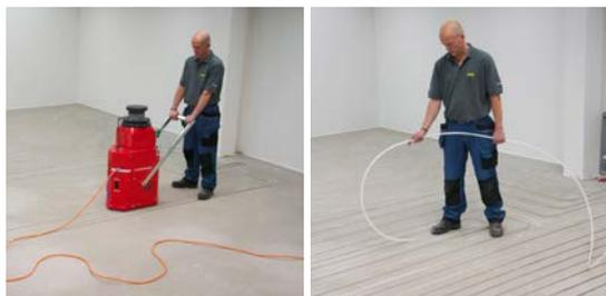
**DAIKIN cut** ist eine nachträglich eingefräste Fußbodenheizung, die direkt in den bestehenden Estrich eingebracht wird. Dazu werden Kanäle in den Estrich gefräst, in welche die Heizrohre eingelegt werden. Generell müssen DAIKIN cut Anlagen wärmetechnisch geplant werden, die Mindestfläche beträgt 40 m<sup>2</sup>. Bitte berücksichtigen Sie bei der Planung eine Vorlaufzeit von 30 Arbeitstagen ab Auftragserteilung.
