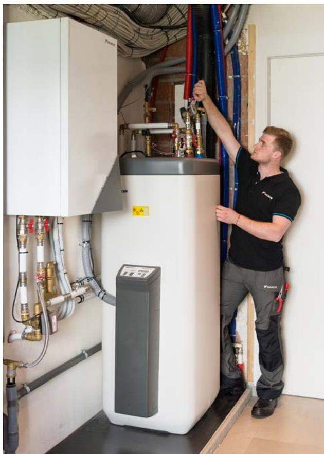
Beispiel eines Systems mit ECH<sub>2</sub>O Wärmespeicher DAIKIN Altherma ST (Speicher mit Regelungs- und Pumpeneinheit RPS4 zur Einbindung einer Solaris Drain-Back Solaranlage)
