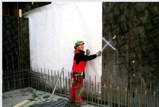
Mechanische Fixierung am Konstruktionsbeton mit entsprechender Befestigung. Unser BPA-SilverSeal kann dabei durchgenagelt oder geklebt werden. Diese Stellen dichten sich automatisch und zuverlässig.
