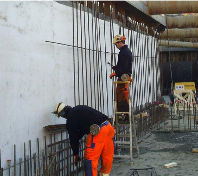
Das BPA-SilverSeal Quellvlies ist eine „aktive“ Flächenabdichtung, die speziell für die Bauwerksabdichtung entwickelt wurde. Das SilverSeal ist ein mechanisch verfestigtes, thermofixiertes wasserreaktives PP-Vlies mit einseitig aufkaschierter PE-Folie, wobei in die PP-Fasern ein wasser-absorbierendes und quellendes Spezialpolymer eingearbeitet ist.
