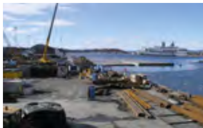
Bjørvikatunnel I Oslo, Norwegen
