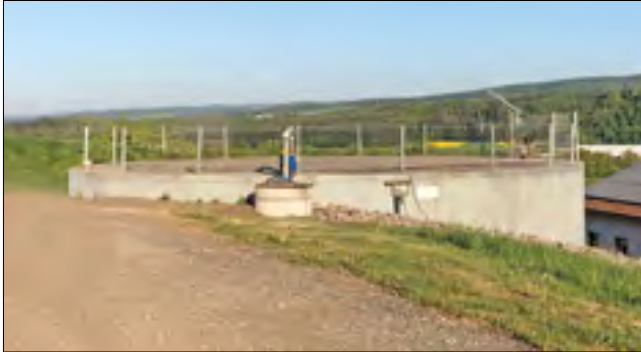
Güllebehälter, Sammelgruben und Erdbecken
