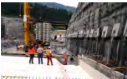
Tunnel Küblis, Schweiz
