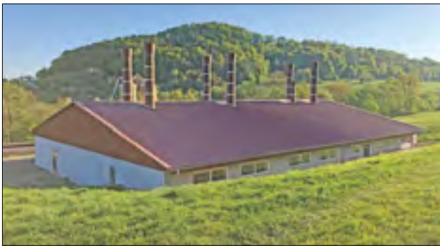
Stallungen mit Güllekeller und -Kanälen
