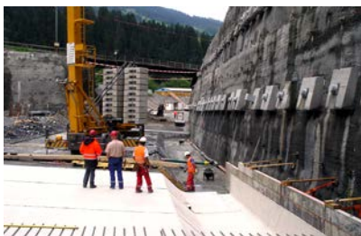
Tunnel Küblis | Schweiz
