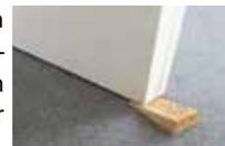
Die Errichtung einer regelkonformen Feststellanlage ist die einzig zulässige Maßnahme, um Feuerschutzabschlüsse so lange offen zu halten, wie es der Betriebsablauf erfordert und gleichzeitig ihr zuverlässiges Schließen im Brandfall sicherzustellen.
