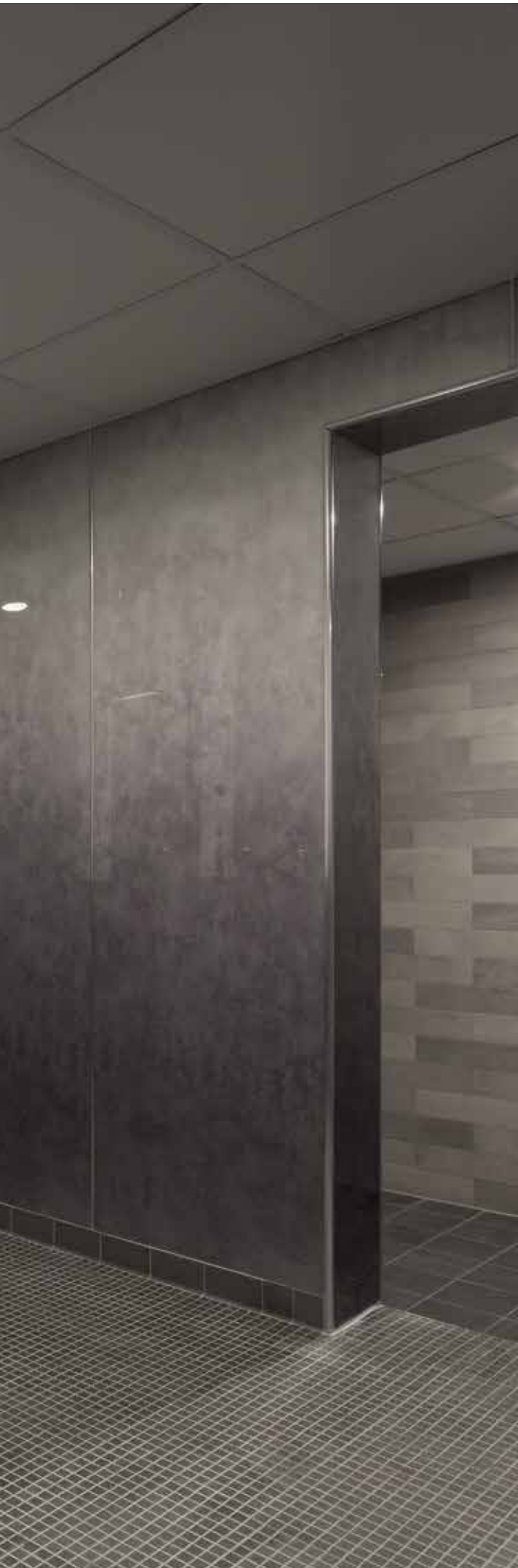
Renovierter Nassbereich eines Fitnessstudios in Köln mit PanElle Wandverkleidung im Design Stahl
