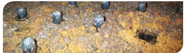
Behälter/Filterboden nach Entleerung mit starken Filtermaterialverblockungen im Düsenbereich
