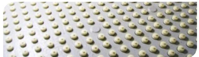
Sanierter Behälter mit Veolia Filterdüsen
