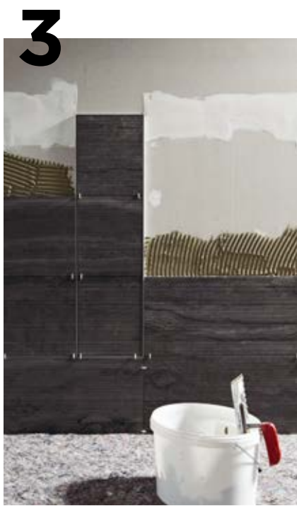
Nachdem die nun verfliesete Tür wieder eingesetzt ist, kann die restliche Verfliesung der Wand beginnen.
