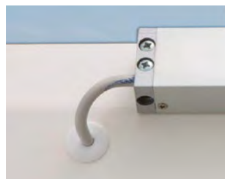
Verdeckte Kabelführung für innenliegende Kettenschubmotoren
