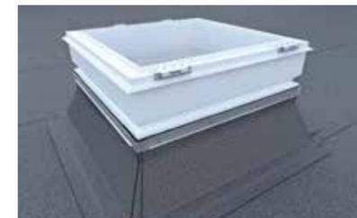
Aufsetzen Sanierungskranz, ausrichten und verschrauben
