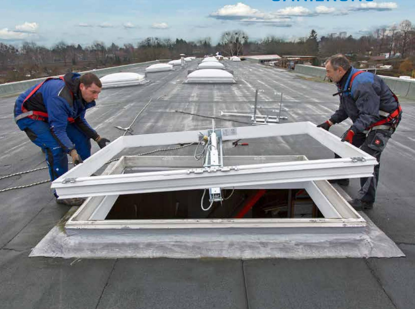
Sanierungslösungen für Lichtkuppeln, Flachdachfenster,
