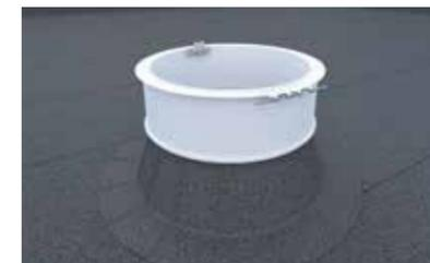
Aufsetzen Sanierungskranz, ausrichten und verschrauben
